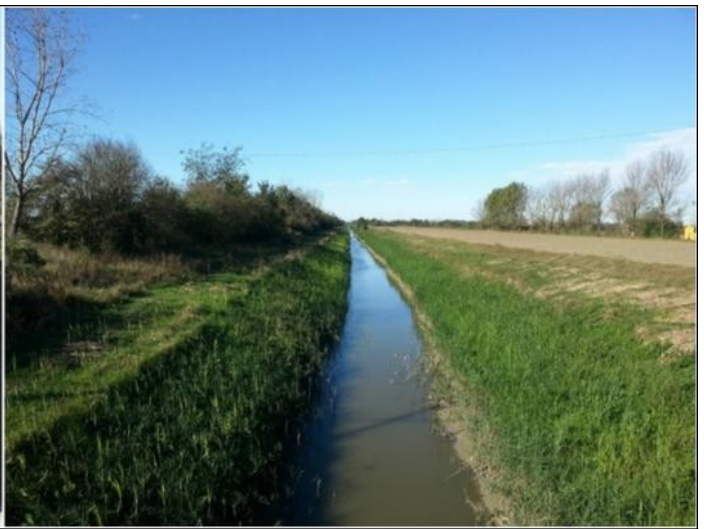
Collettore Acque Basse Modenesi
