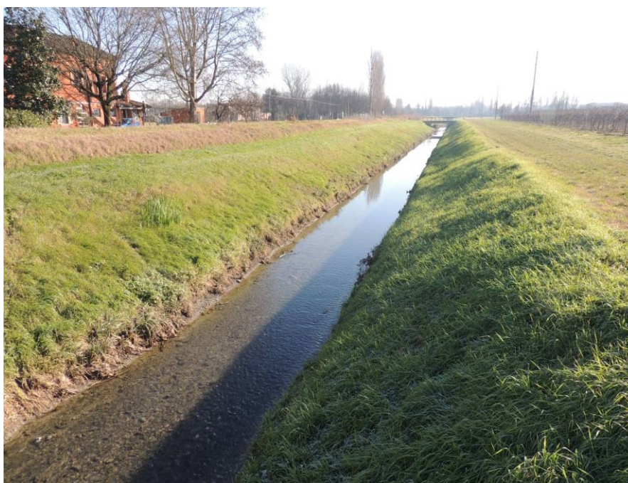
Diversivo Fossa Nuova Cavata.
