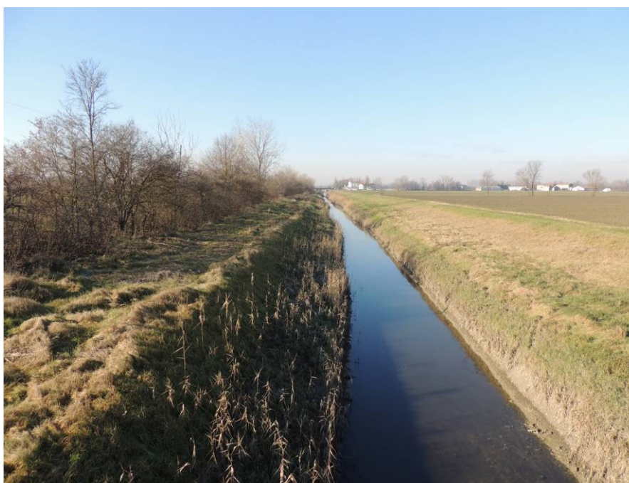
CABM - Collettore Acque Basse Modenesi.
