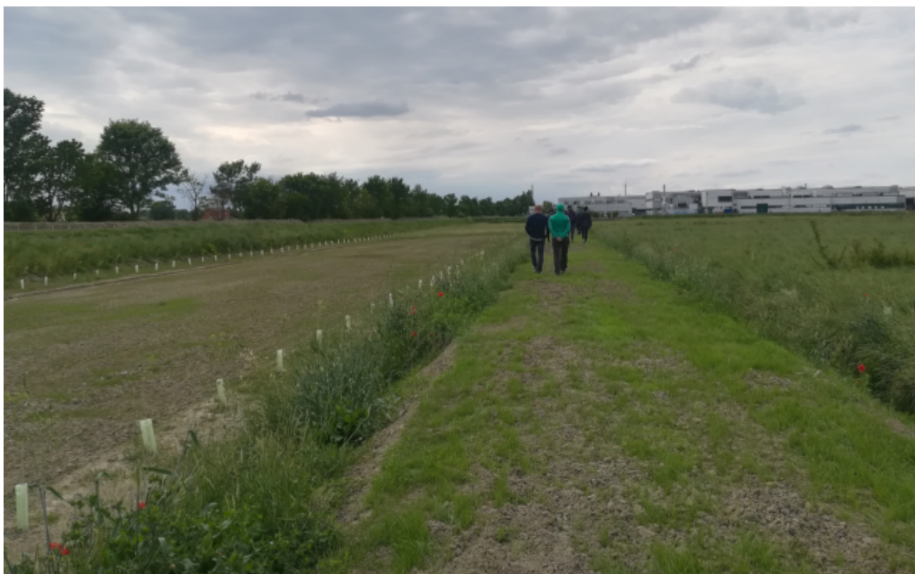
Figura 71 – Argine perimetrale della cassa di espansione a servizio della Cavata Orientale. Si notano gli shelter a protezione della fascia arbustiva messa a dimora al piede dell'argine (maggio 2019)
