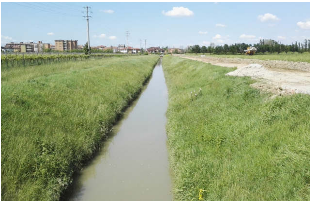
Figura 38 - Diversivo Fossa Nuova Cavata – Pre lavori (2015)
