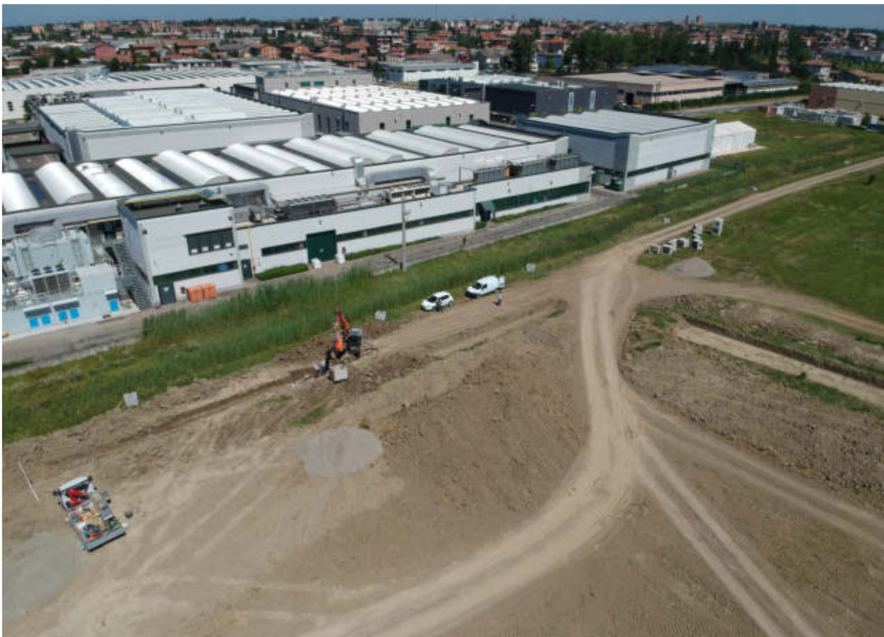
Figura 66 – Scavo della cassa di espansione a servizio della Cavata Orientale (2018)
