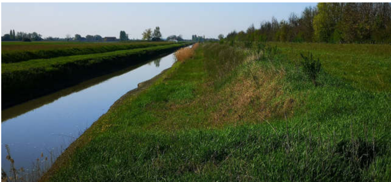
Figura 104 – Collettore Acque Basse Modenesi – Novi di Modena (aprile 2020).
