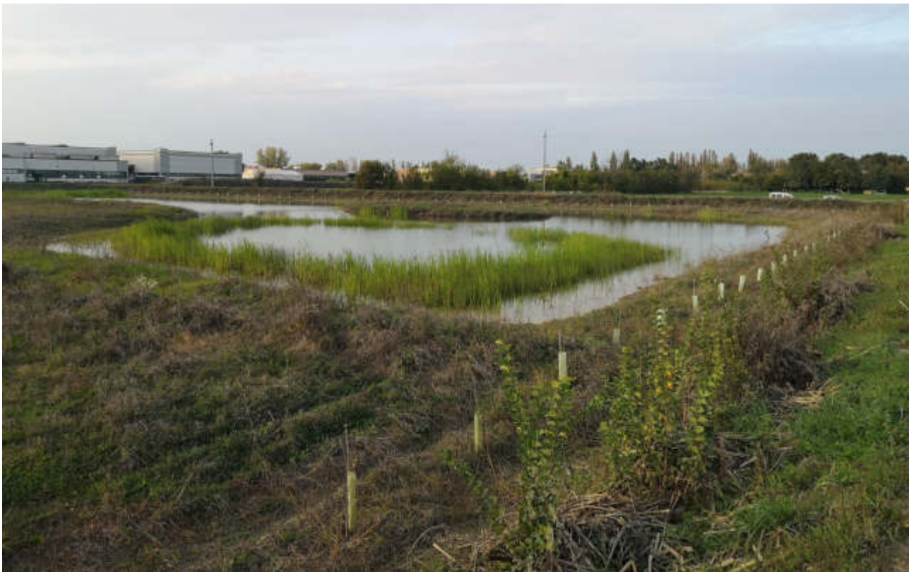
Figura 77 – Zona umida all'interno della cassa di espansione a servizio della Cavata Orientale (ottobre 2019).
