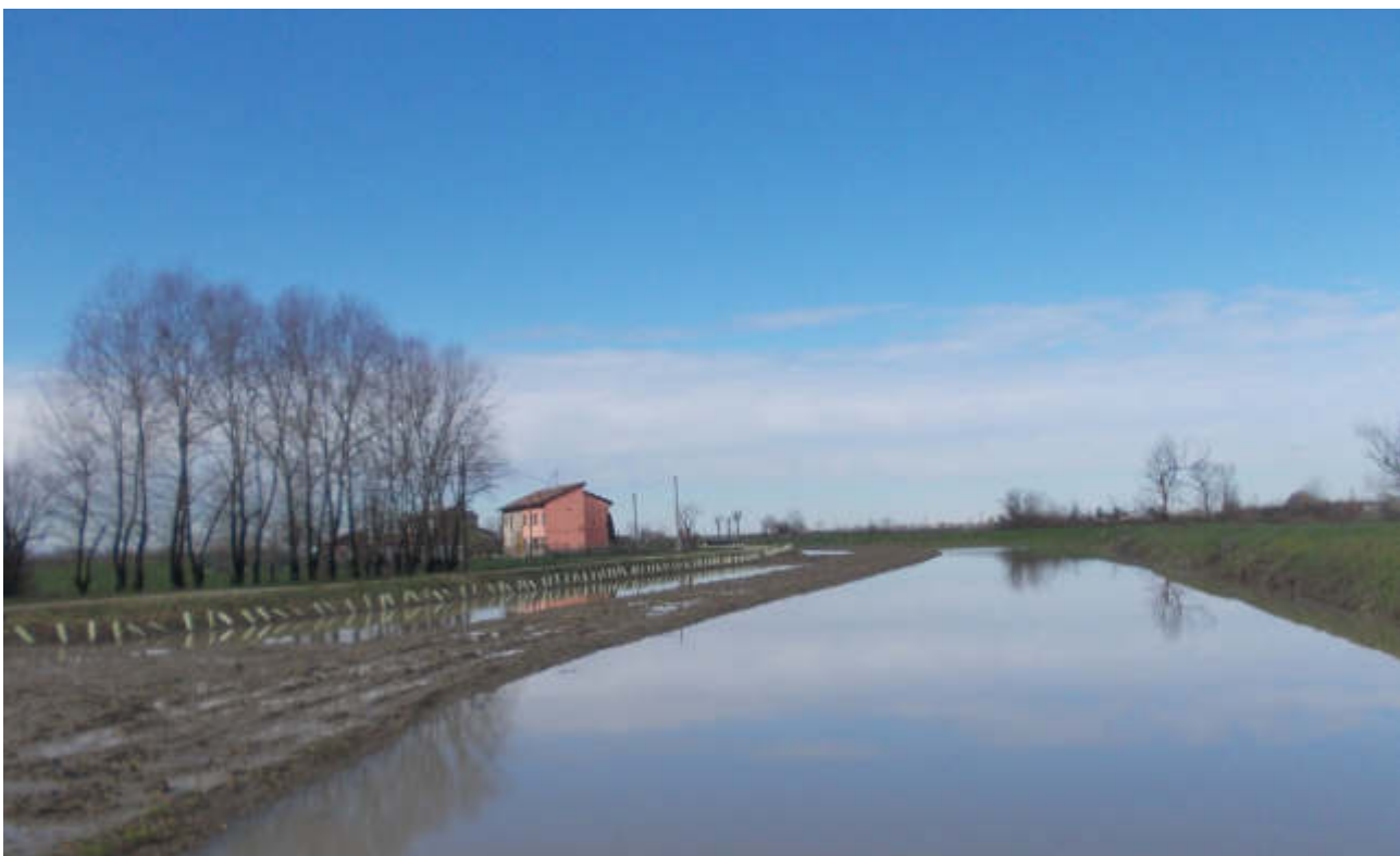
Figura 24 – Collettore Alfieri a due mesi dagli scavi: prime piogge. Collettore in primo piano e bassura umida sullo sfondo (febbraio 2016)
