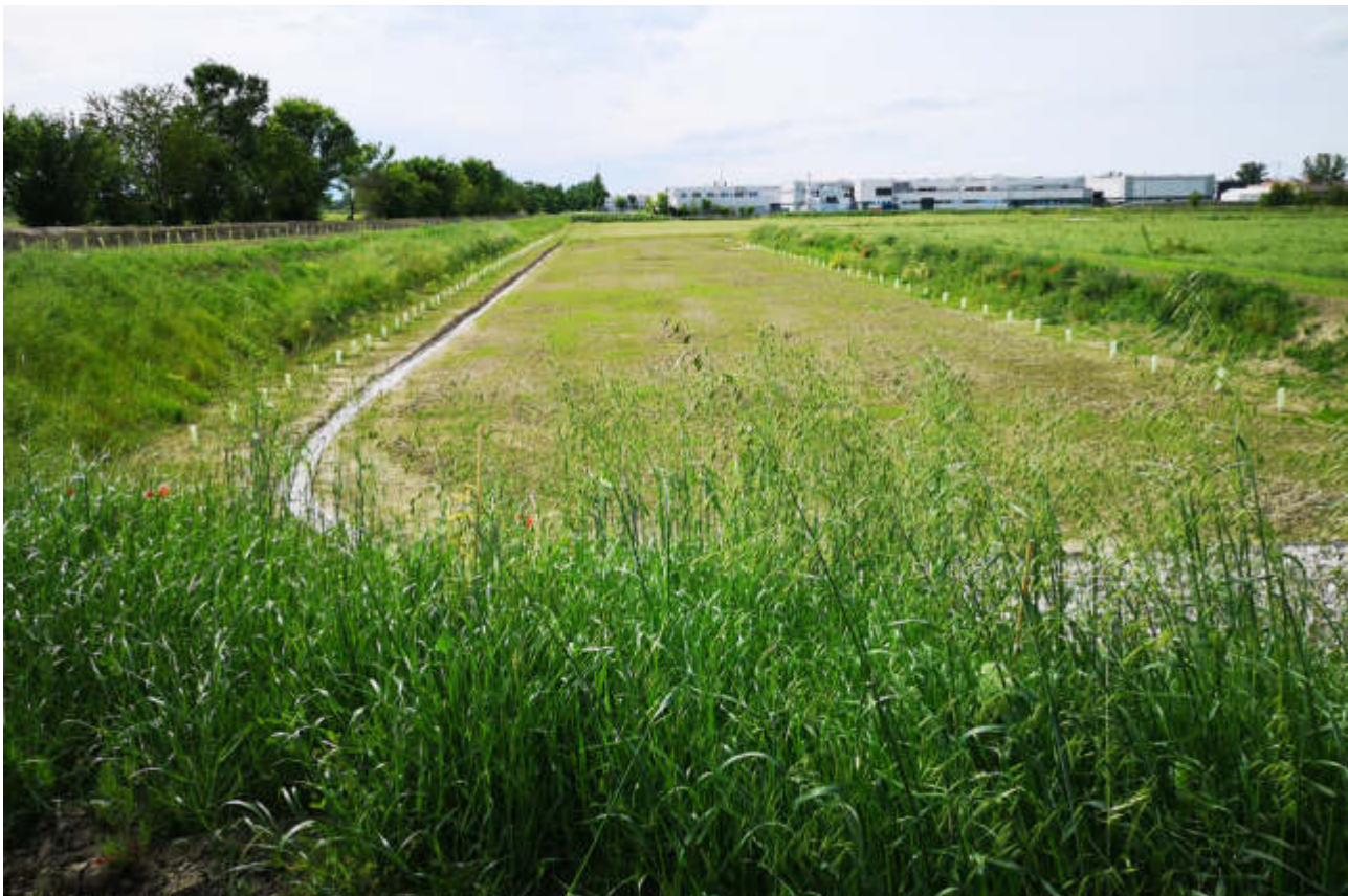
Figura 70 - Cassa di espansione a servizio della Cavata Orientale. In primo piano il lembo di cassa che si raccorda con la tubazione di uscita. Colonizzazione della vegetazione erbacea (maggio 2019).
