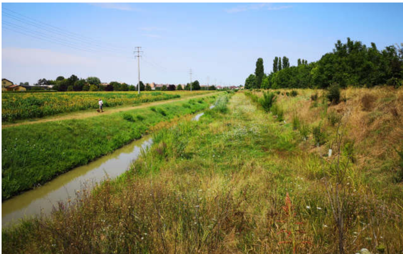
Figura 50 - Diversivo Fossa Nuova Cavata – Particolare della banchina allagabile – Inizio colonizzazione vegetazione (luglio 2020)
