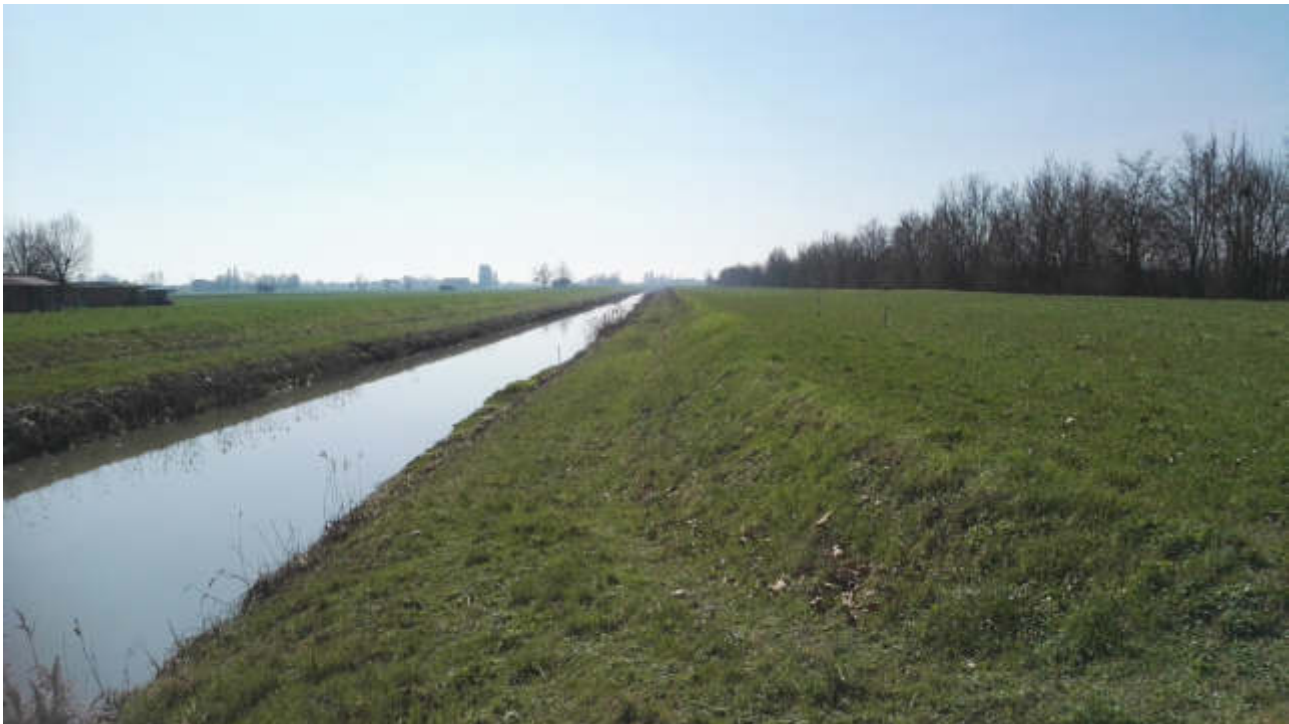
Figura 97 – Collettore Acque Basse Modenesi – Novi di Modena – Ante operam (2015).
