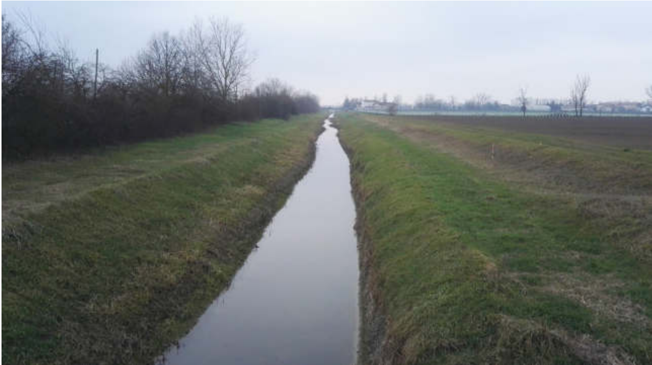
Figura 92 – Collettore Acque Basse Modenesi – Carpi – Ante operam (2015).
