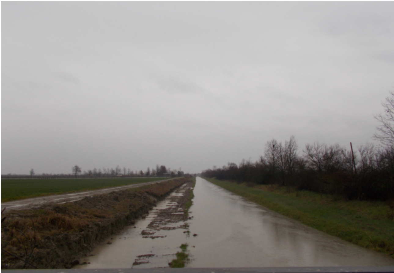
Figura 96 – Collettore Acque Basse Modenesi – Carpi – Banchina allagabile appena scavata e soggetta ad allagamento (febbraio 2016).
