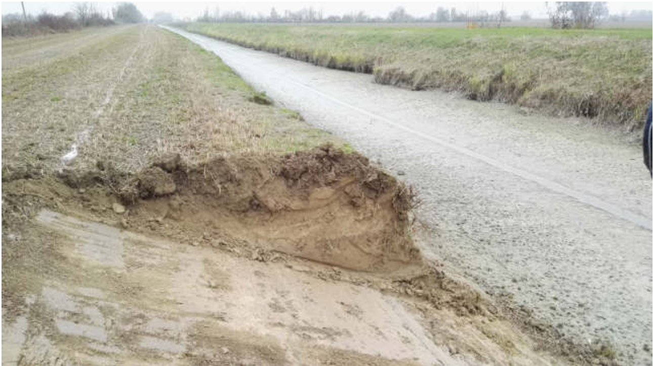
Figura 19 – Collettore Alfieri. Riprofilatura della sponda (autunno 2015)
