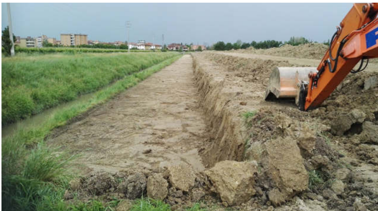
Figura 42 - Diversivo Fossa Nuova Cavata – Scavo della banchina allagabile (2016)
