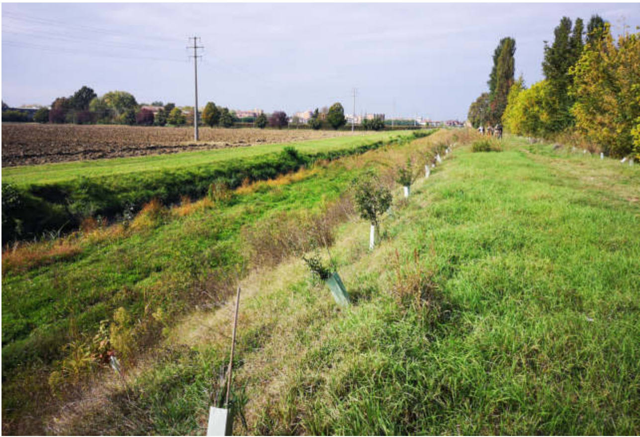
Figura 47 - Diversivo Fossa Nuova Cavata – Fascia riparia messa a dimora sul ricoprimento del Condotto Gusmea (ottobre 2019)
