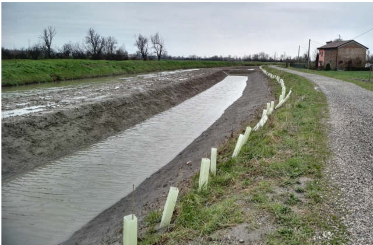
Figura 22 – Collettore Alfieri a due mesi dagli scavi: prime piogge. Particolare di una bassura umida (febbraio 2016)
