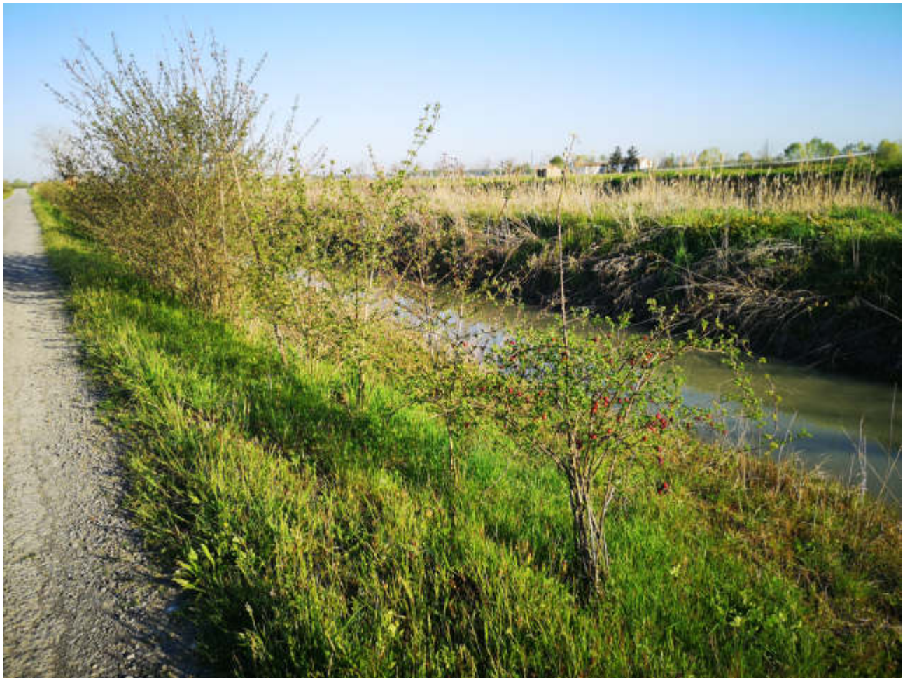
Figura 31 – Collettore Alfieri. Colonizzazione vegetazione. Particolare della fascia riparia messa a dimora (aprile 2020)
