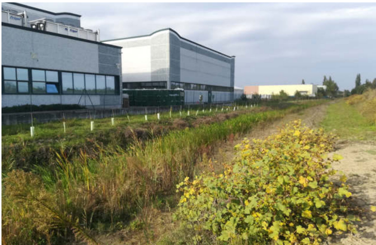
Figura 83 – Banchina allagabile scavata lungo la Cavata Orientale. Inizio della colonizzazione della vegetazione (ottobre 2019)
