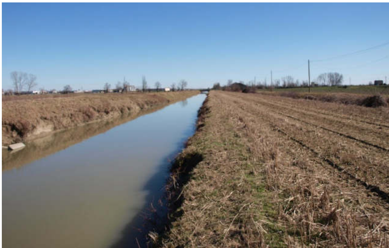
Figura 5 – Collettore Alfieri prima della realizzazione degli interventi (2009). A destra la banca oggetto di intervento (larghezza variabile dai 10 ai 20 m)
