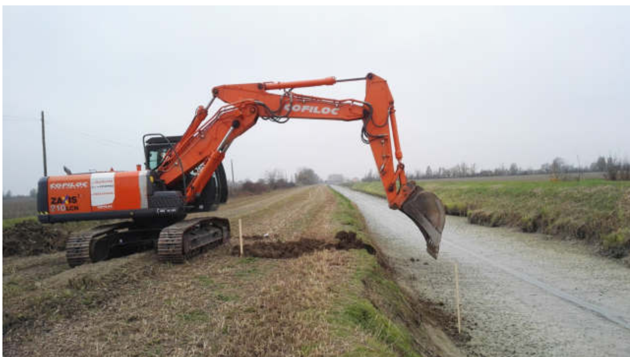
Figura 18 – Collettore Alfieri. Riprofilatura della sponda (autunno 2015)
