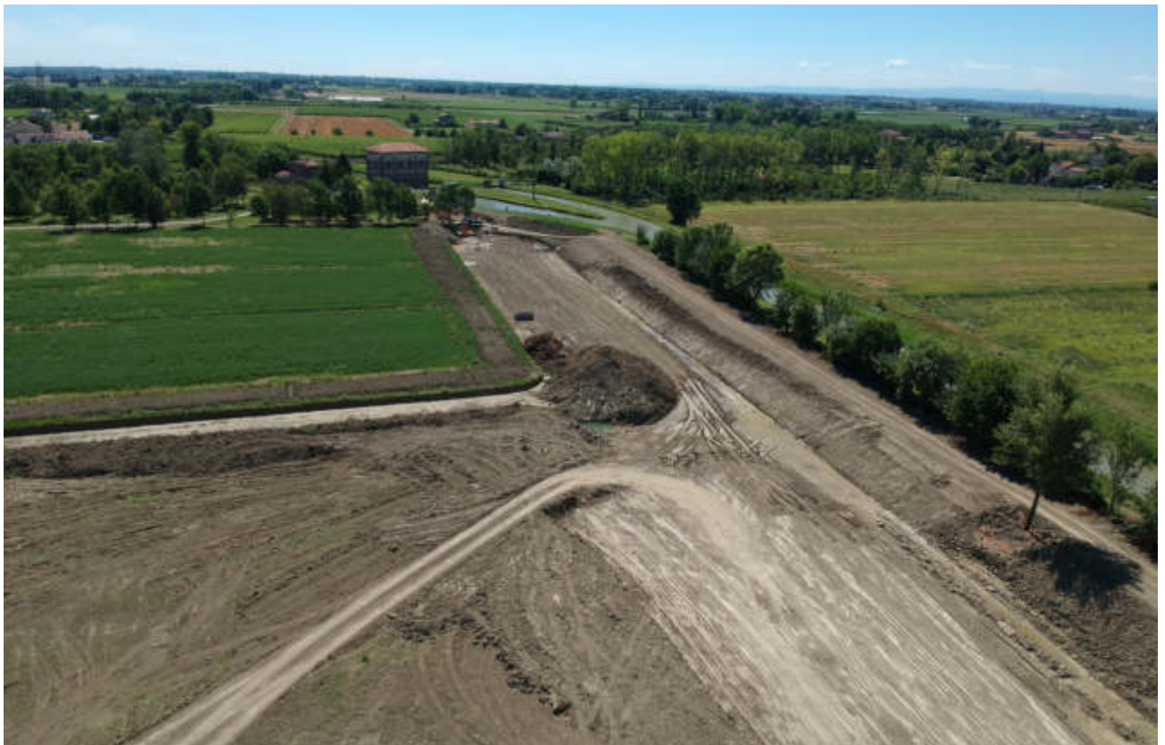
Figura 67 – Scavo della cassa di espansione a servizio della Cavata Orientale. Sullo sfondo il lembo di cassa che si raccorda con la tubazione di uscita (2018)
