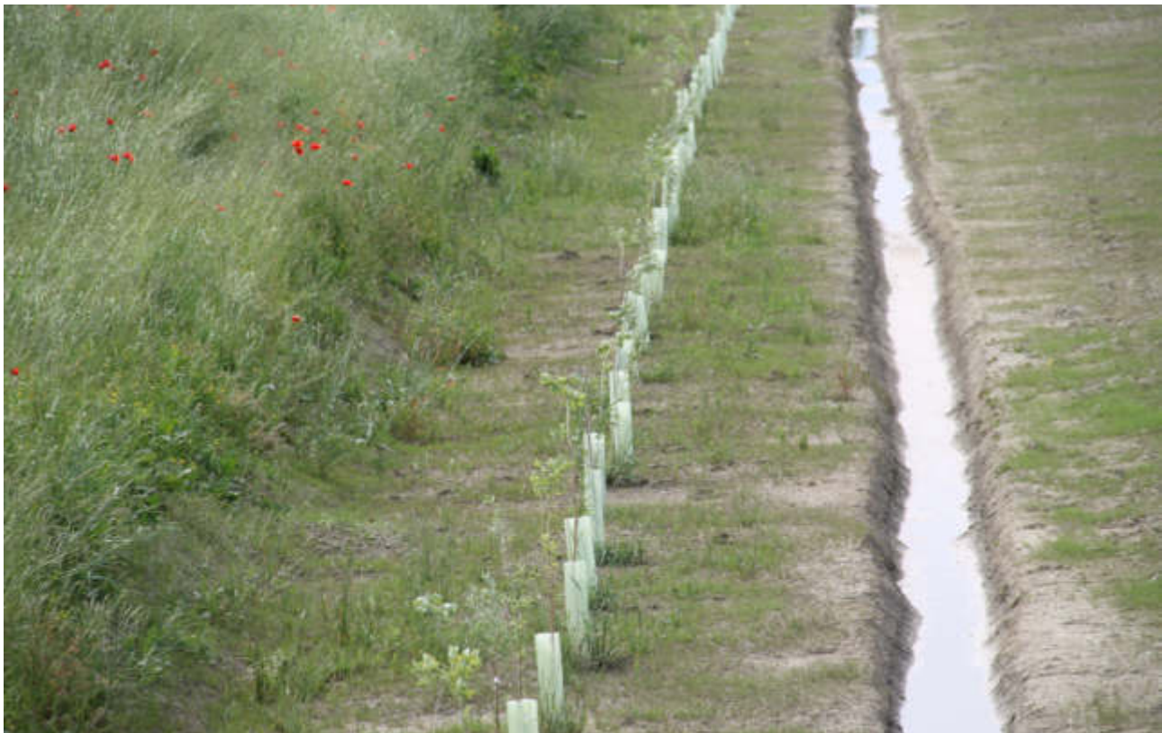
Figura 72 – Argine perimetrale della cassa di espansione a servizio della Cavata Orientale. Si notano gli shelter a protezione della fascia arbustiva messa a dimora al piede dell'argine (maggio 2019)
