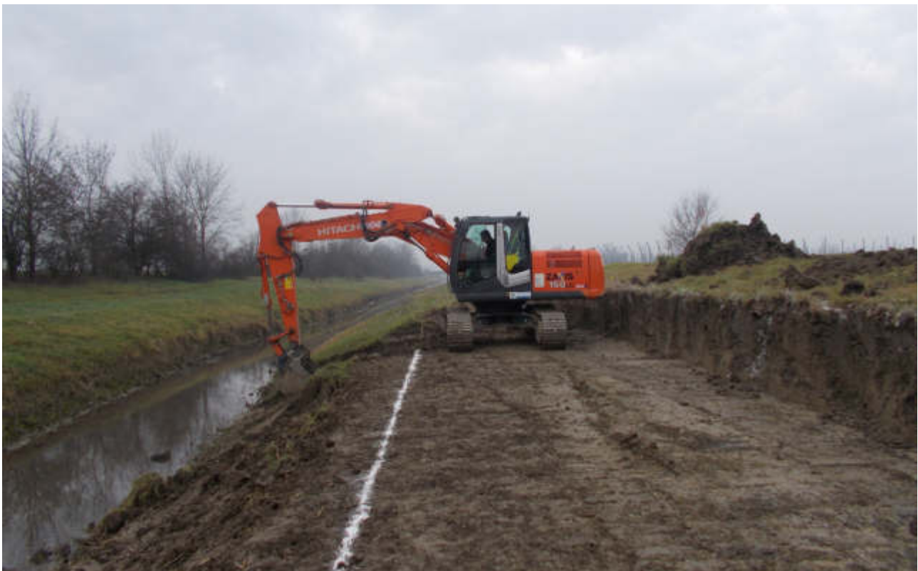
Figura 93 – Collettore Acque Basse Modenesi – Carpi – Creazione della banchina allagabile (2015).
