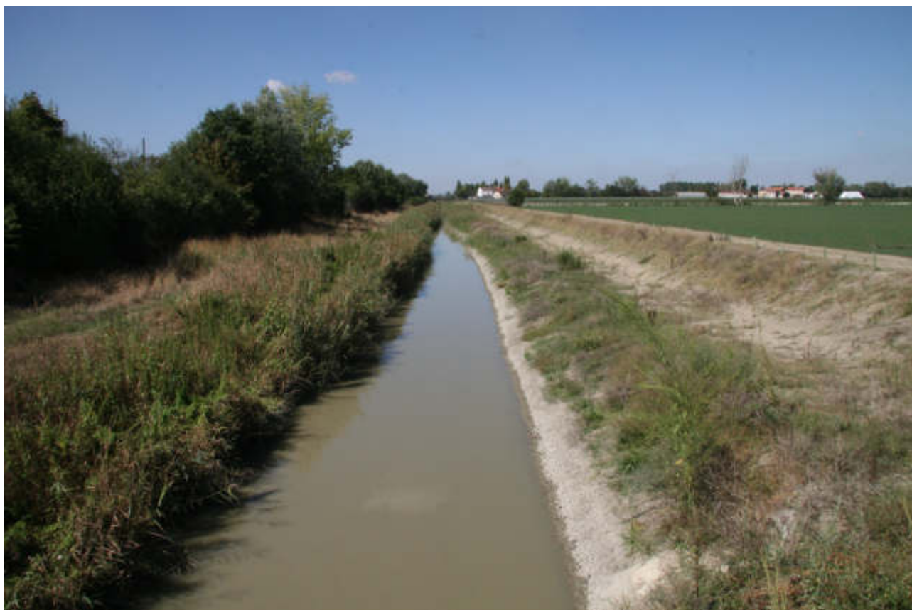
Figura 94 – Collettore Acque Basse Modenesi – Carpi – Banchina allagabile appena scavata (2015).
