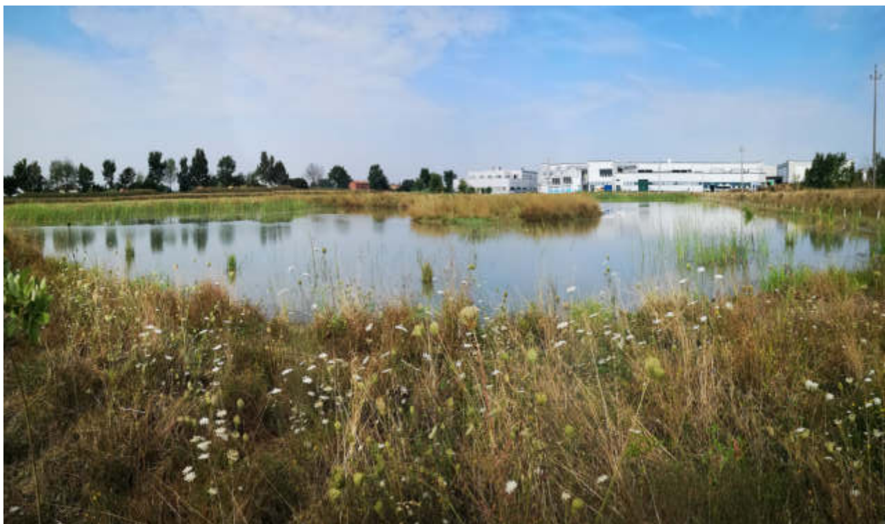
Figura 79 – Zona umida all'interno della cassa di espansione a servizio della Cavata Orientale (luglio 2020)*
