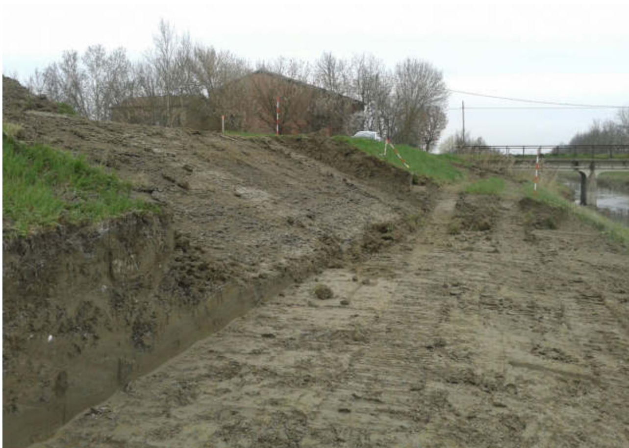
Figura 98 – Collettore Acque Basse Modenesi – Novi di Modena- Creazione della banchina allagabile (2015).
