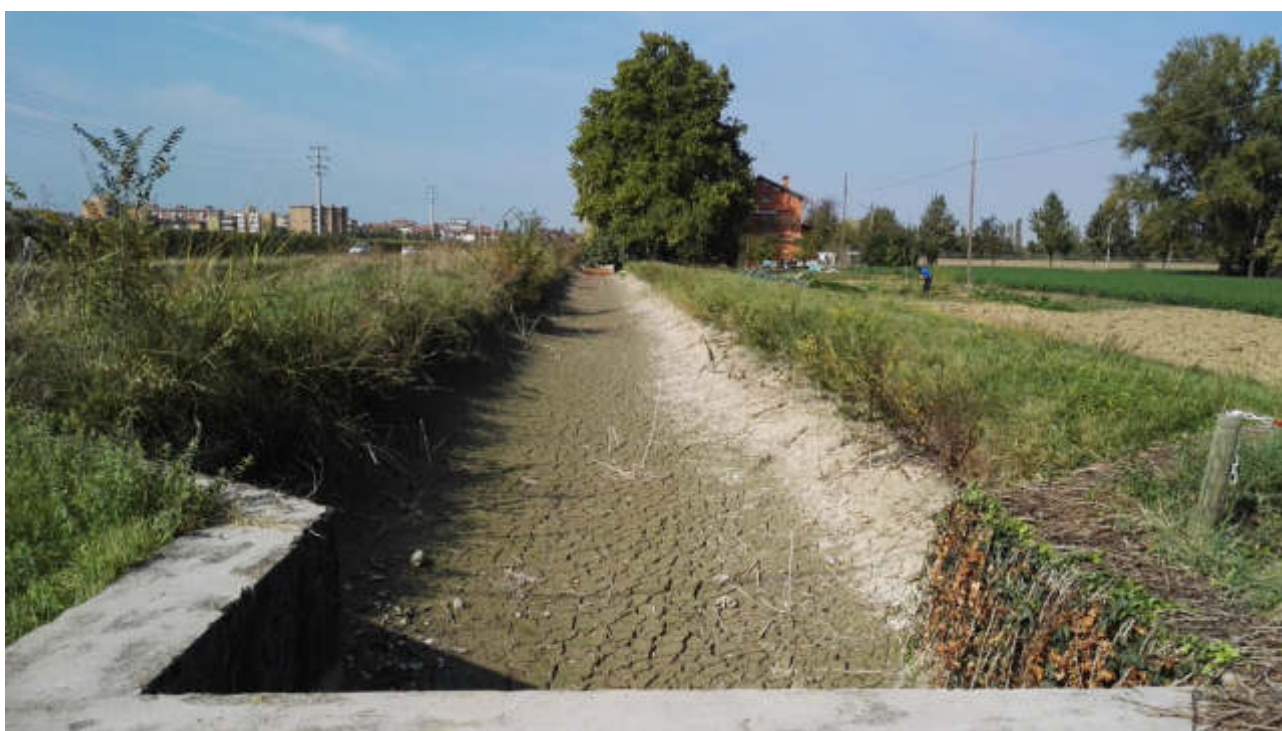
Figura 39 - Diversivo Fossa Nuova Cavata – Pre lavori. Particolare Condotto Gusmea (2015)
