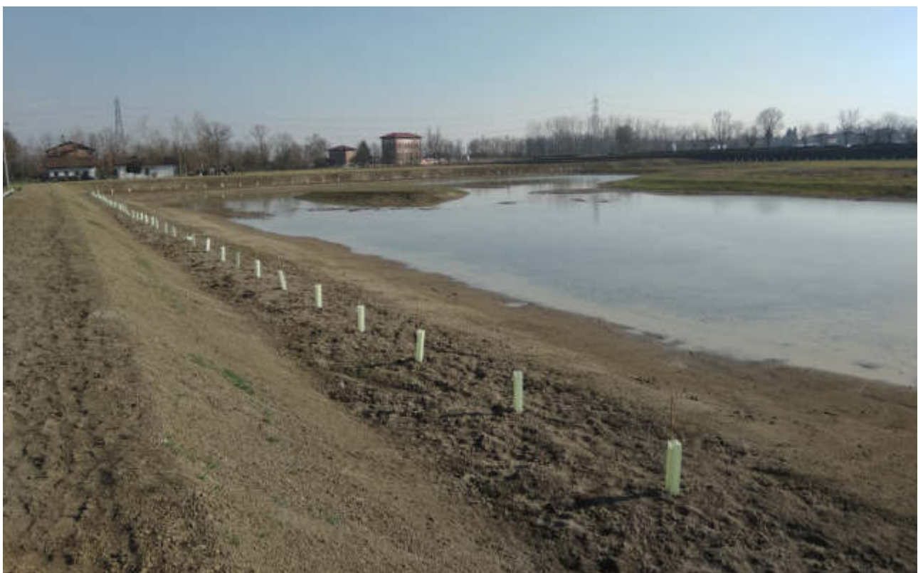
Figura 73 – Zona umida all'interno della cassa di espansione a servizio della Cavata Orientale. In primo piano gli shelter a protezione della fascia arbustiva messa a dimora (inizio 2019)
