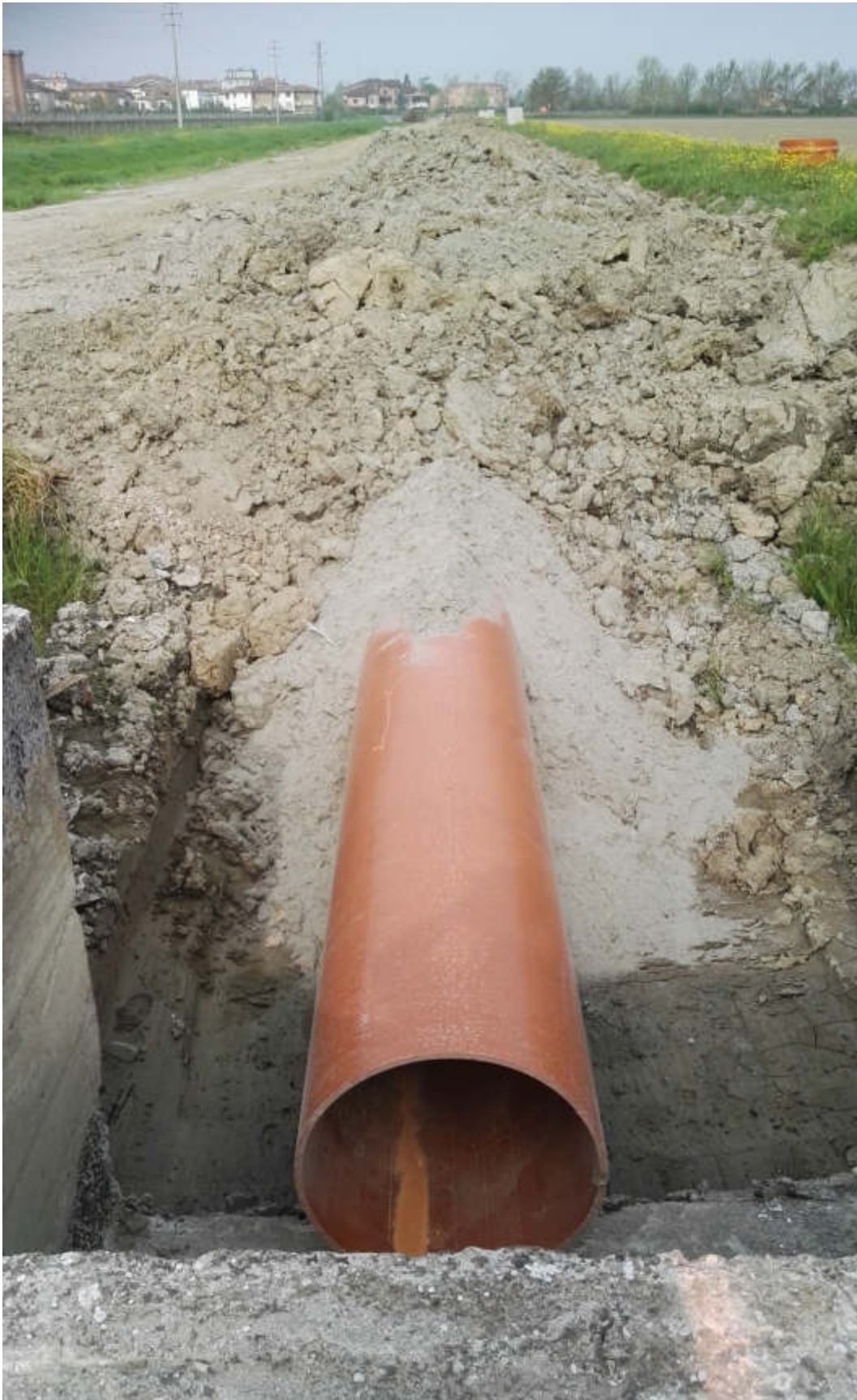
Figura 40 - Diversivo Fossa Nuova Cavata – Tubazione sostitutiva del Condotto Gusmea (2016)
