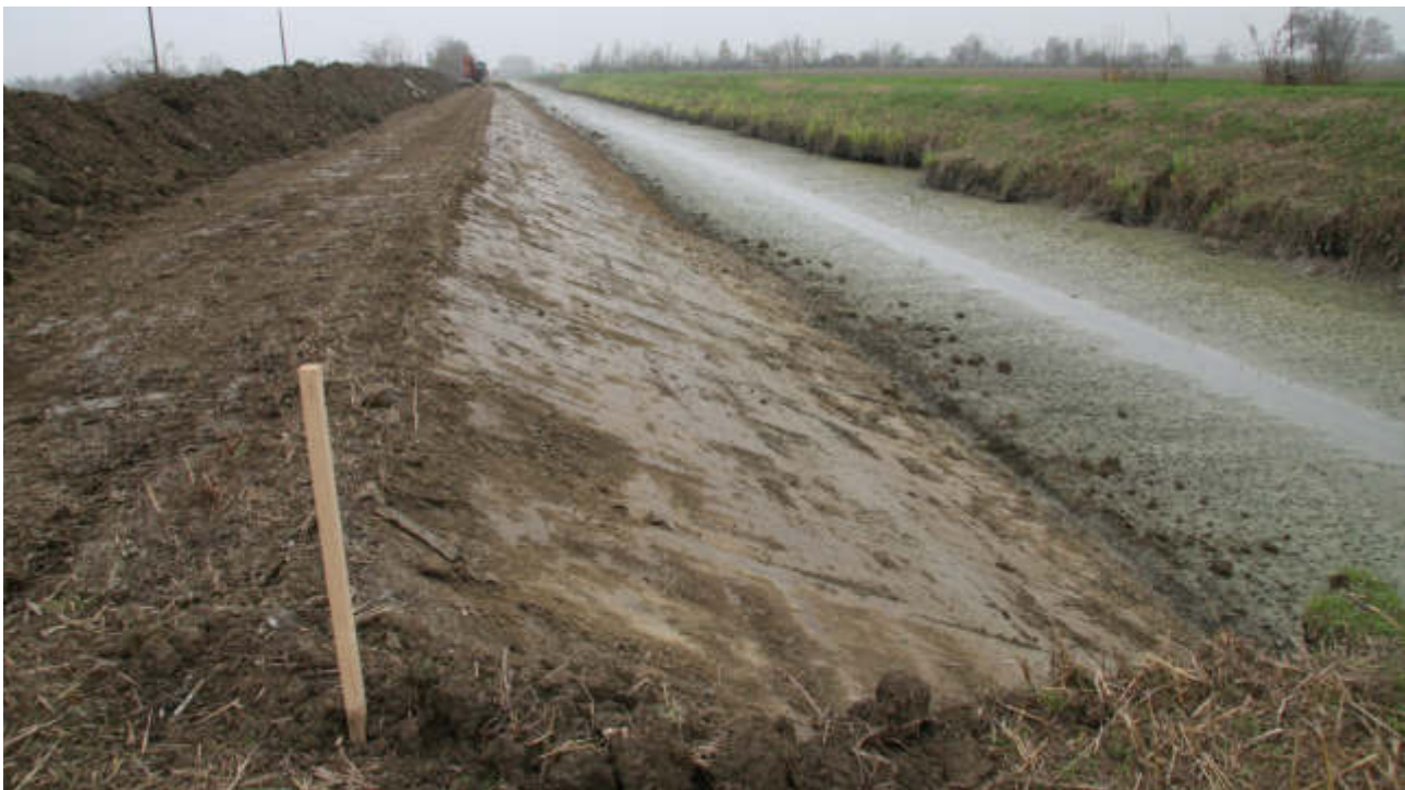
Figura 20 – Collettore Alfieri. Riprofilatura della sponda (autunno 2015)
