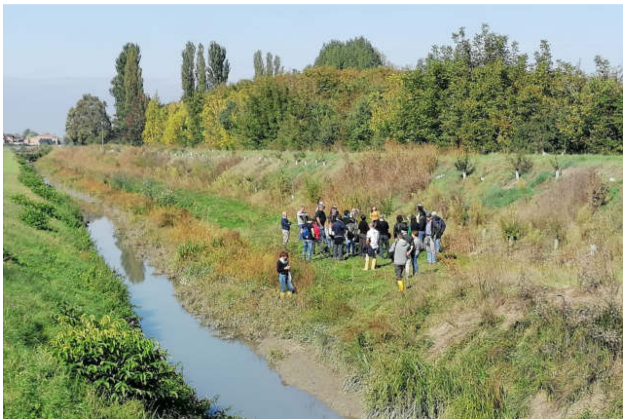
Figura 46 - Diversivo Fossa Nuova Cavata – Banchina allagabile – Inizio colonizzazione vegetazione (ottobre 2019)
