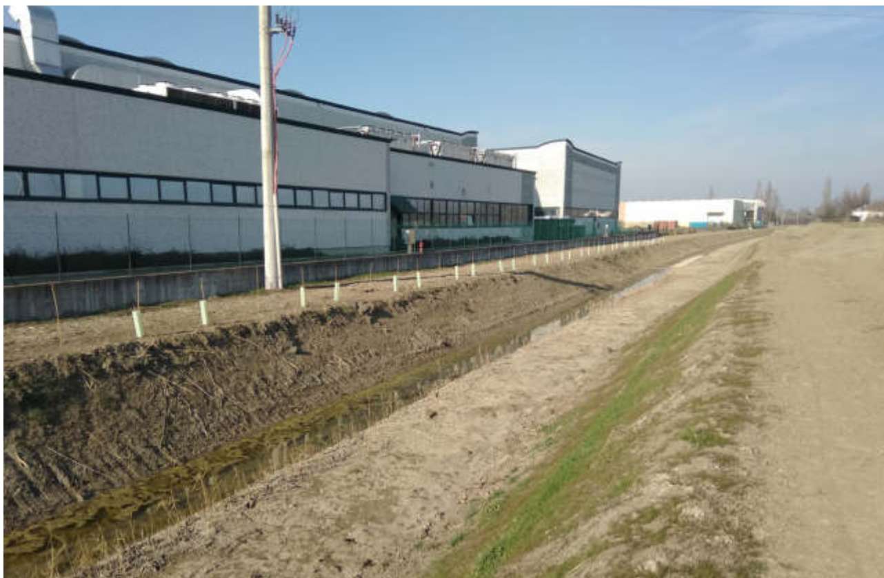
Figura 82 – Banchina allagabile scavata lungo la Cavata Orientale (inizio 2019)
