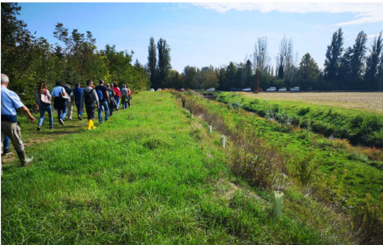
Figura 48 - Diversivo Fossa Nuova Cavata – Fascia riparia messa a dimora sul ricoprimento del Condotto Gusmea (ottobre 2019)
