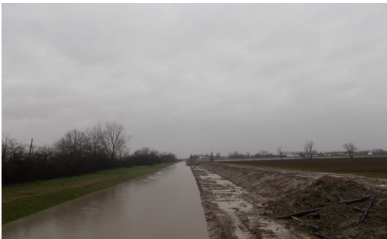
Figura 95 – Collettore Acque Basse Modenesi – Carpi – Banchina allagabile appena scavata e soggetta ad allagamento (febbraio 2016).
