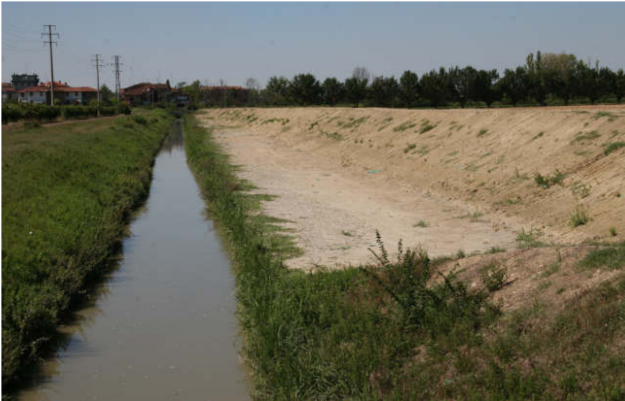
Figura 43 - Diversivo Fossa Nuova Cavata – Banchina allagabile (2016)
