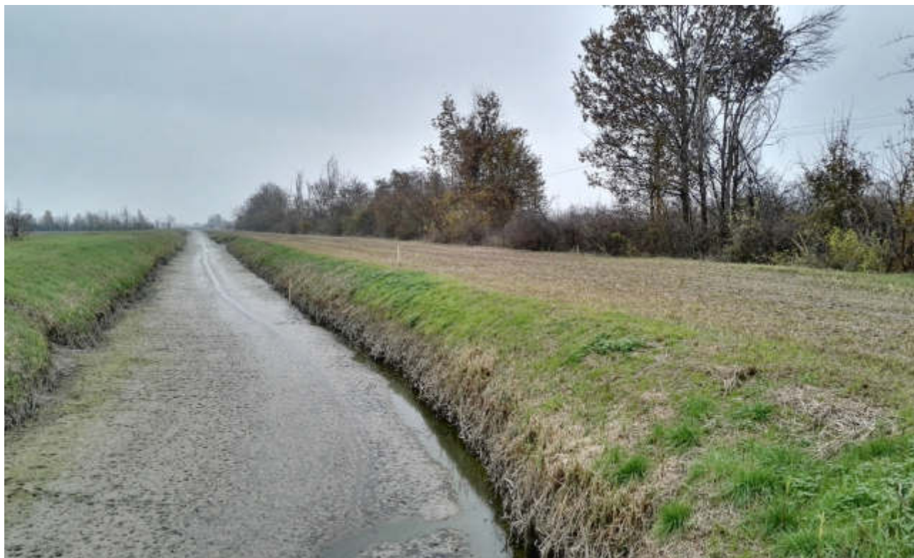
Figura 9 – Tratto 2 di intervento sul Collettore Alfieri, vista verso valle (alveo a sinistra, banca esistente a destra)
