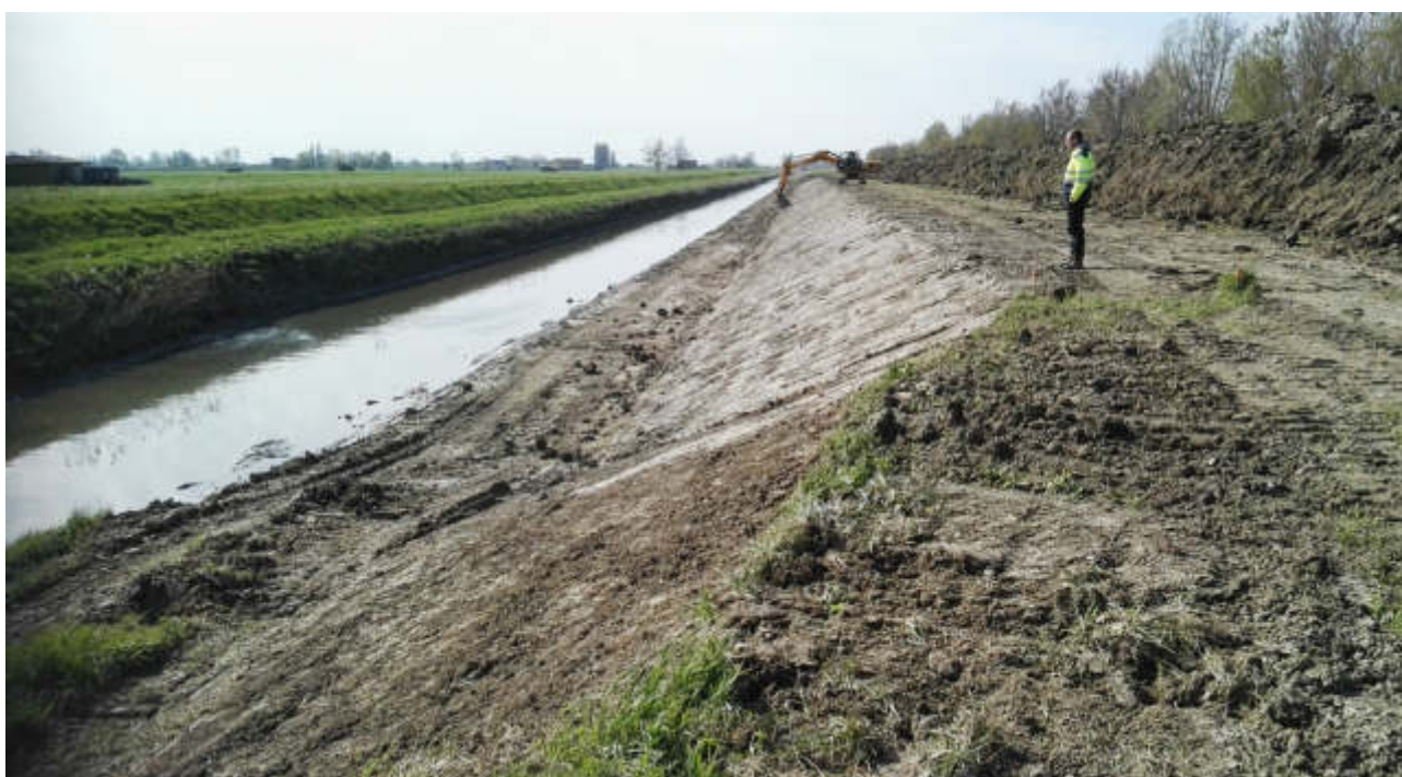
Figura 99 – Collettore Acque Basse Modenesi – Novi di Modena- Creazione della banchina allagabile (2015).
