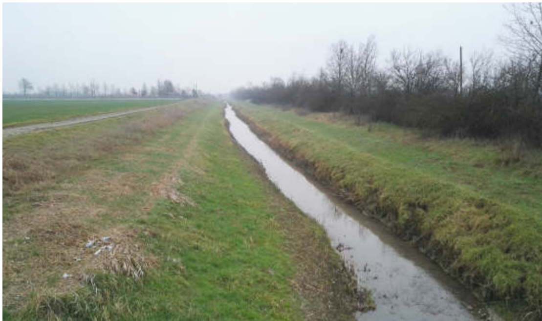
Figura 89 – Tratto 1 di intervento sul CABM. In alto: il canale nel primo sub-tratto (vista da valle verso monte in corrispondenza del Ponte di via degli Inglesi). In basso: il canale nel secondo sub-tratto (vista da monte verso valle in corrispondenza del ponte di via degli Inglesi)
