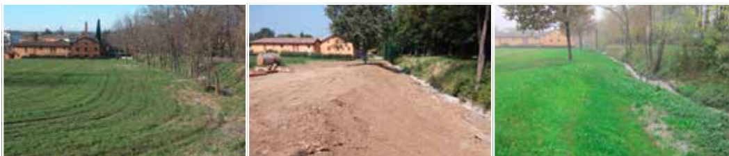
Figura 3 – Un altro esempio di allargamento di un rio (Rio Bianello) in sponda sinistra. In questo caso l'intervento è stato realizzato subito a monte di un tratto urbano, dove il rio diviene tombinato, e in una porzione limitrofa ad un terreno ad uso agricolo.
