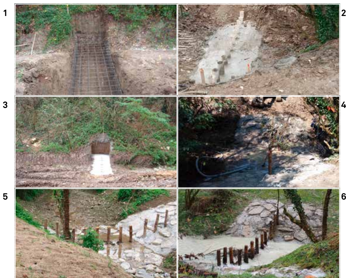
Figura 17 – Sequenza delle fasi di realizzazione di una briglia selettiva sul rio Bertolini.
