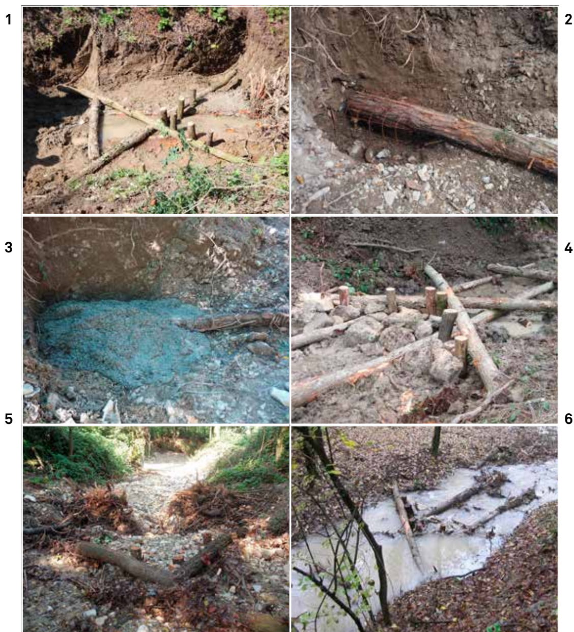
Figura 14 – Sequenza delle fasi di realizzazione di un salto di fondo naturaliforme realizzato in tronchi, massi e radici esposte sul Rio Lavezza.
