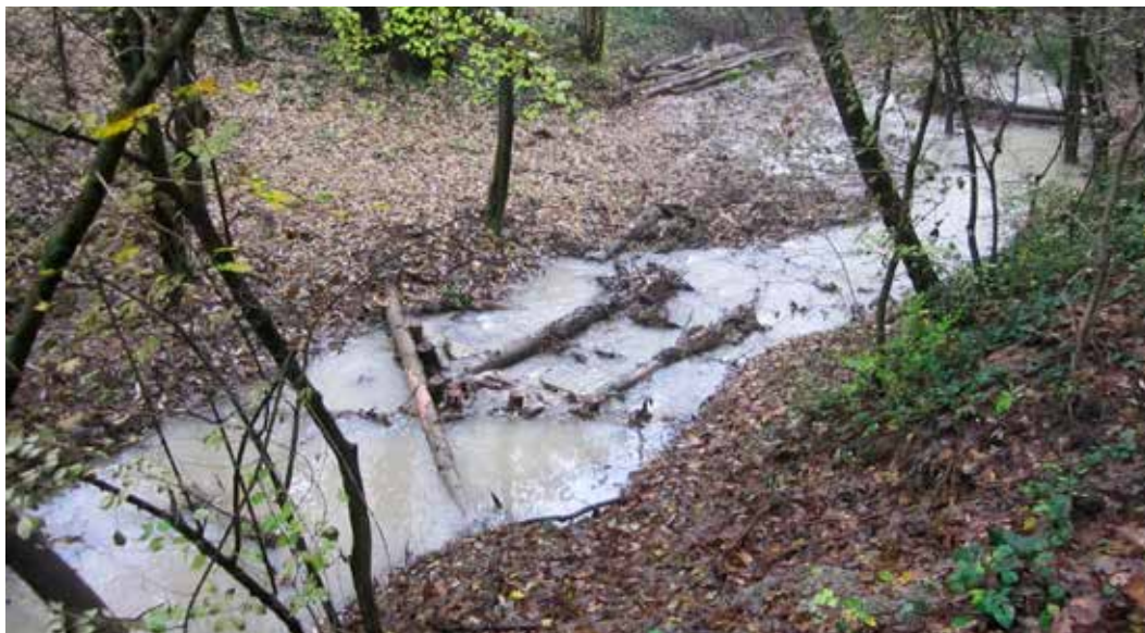
Figura 12 – Esempio di salto di fondo naturaliforme con radici esposte realizzato lungo il Rio Bertolini.
