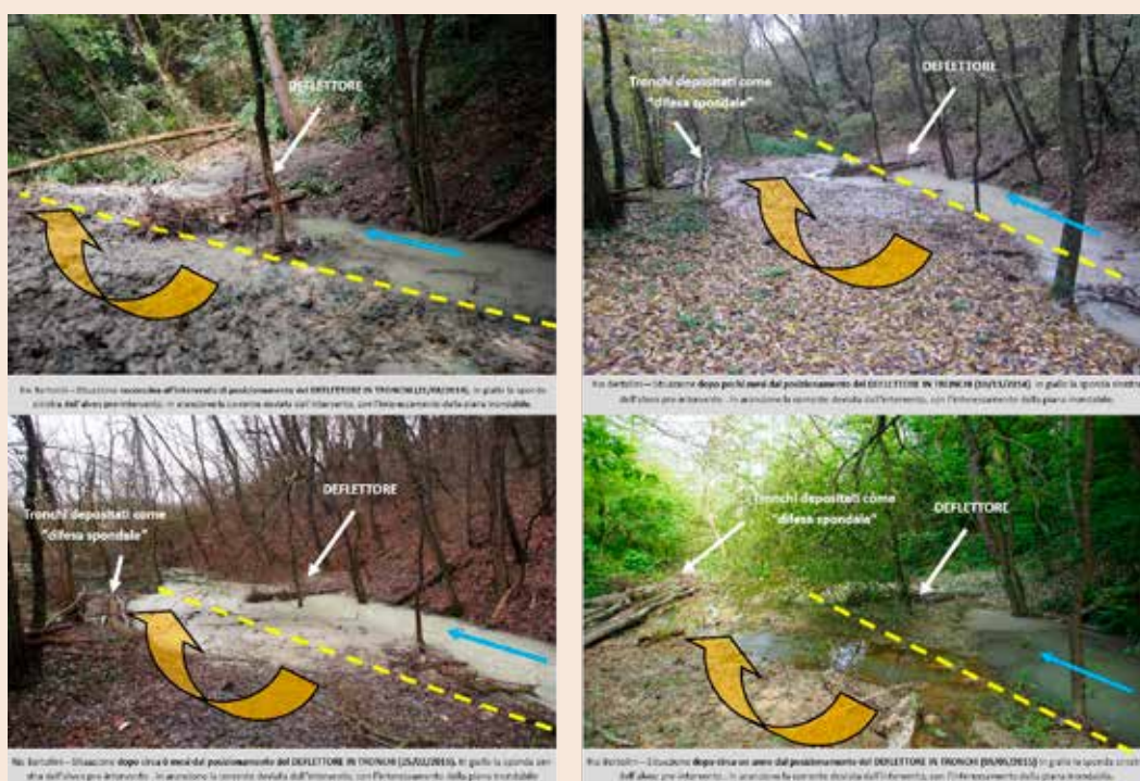
Figura 23 – Esempio di avvio di processi di evoluzione morfologica legati alla realizzazione di un deflettore di corrente sul Rio Bertolini (elaborazione tratta da Monaci, 2016).
