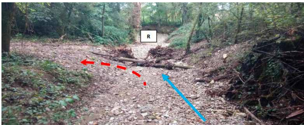
Figura 12 – Esempio di salto di fondo naturaliforme con radici esposte realizzato lungo il Rio Bertolini.
