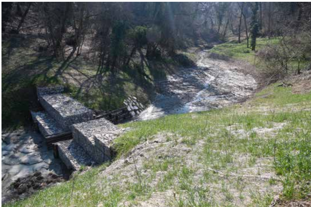
Figura 9 –Restringimento di sezione in pietrame in corrispondenza di un intervento di allargamento dell'alveo per la creazione di piana inondabile realizzato sul Rio Bianello.
