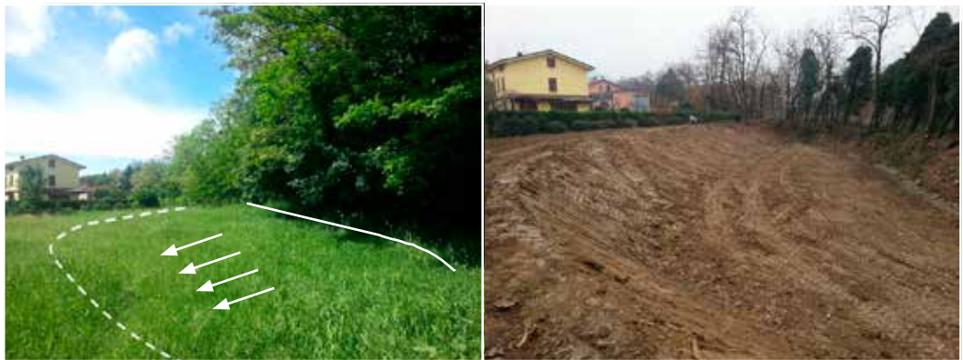
Figura 2 - Schema e foto prima e dopo di un intervento di allargamento dell'alveo realizzato in ambito urbano sul Rio Enzola, nel Comune di Quattro Castella, nell'ambito del progetto LIFE RII (il tratteggio indica il punto di realizzazione del nuovo argine arretrato). Si osservi come in questo caso il piccolo rilevato arginale sia stato spostato in corrispondenza della nuova sponda riprofilata con pendenze molto più degradanti.
