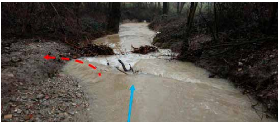
Figura 13 –Intervento di realizzazione di un salto naturaliforme realizzato sul Rio Lavezza. In alto si nota l'intervento appena realizzato, che si inserisce in un alveo dominato dalla presenza prevalente di riffle come unità morfologiche. In basso si nota il come l'intervento, in fase di morbida, tenda a favorire la riconnessione idrologica e morfologica della piana inondabile presente in sponda sinistra.
