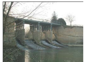
Figura 4 Chiusa storica di S. Marco lungo il f. Montone, in Comune di Ravenna
