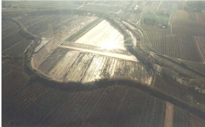
Figura 23 Allagamenti dell'area S. Tomè prima dei lavori
