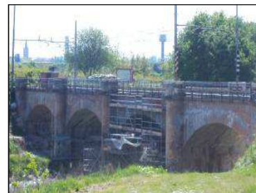
Figura 6 Ponte ferrovia Bologna Ancona sul fiume Montone a Forlì
