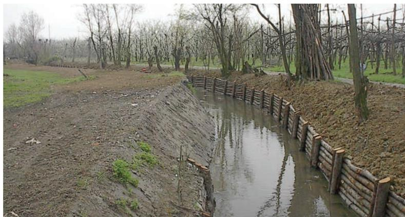
*In basso: la sponda del canale protetta dalla palizzata rinverdita appare in buono stato, mentre le talee di salice non si sono sviluppate a sufficienza come conseguenza del taglio, non previsto dal progetto, effettuato dai proprietari del terreno.*
