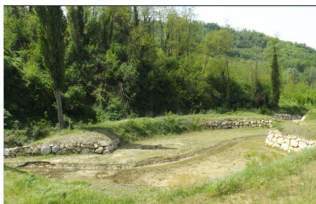
Figura 21 – Area di decantazione torrente Cesuola (particolari pennelli in massi)
