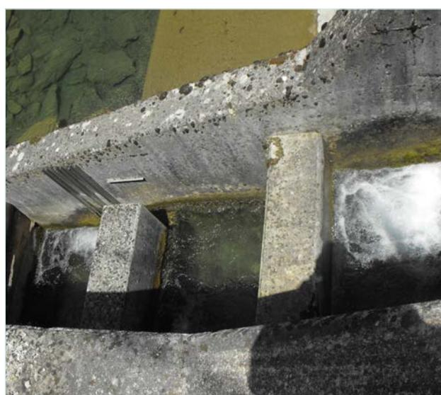
Figura 7 – Passaggio per pesci del tipo a bacini successivi sul torrente Fiumicello, in località Fiumicello (Premilcuore - FC). A) Briglia e opera di presa idropotabile “a trappola”. B) Scala di risalita a bacini successivi in c.a. in cui viene veicolata l’intera portata di DMV
