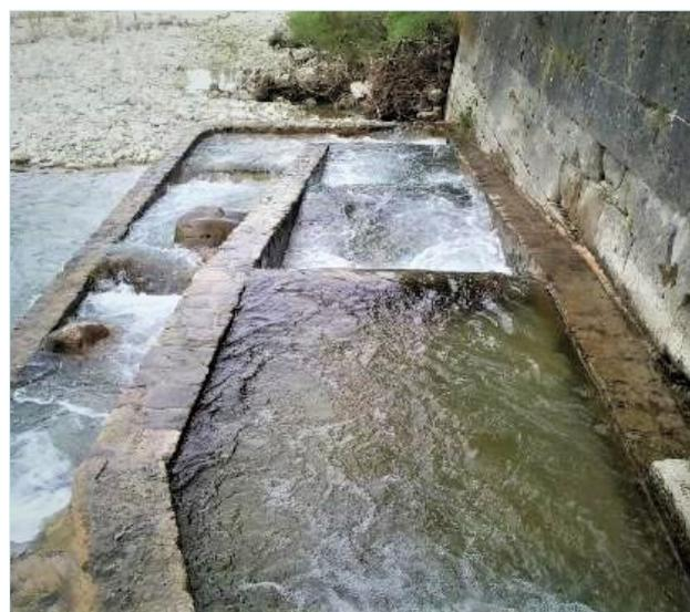
Figura 5 –Passaggio per pesci del tipo tecnico, a bacini successivi realizzato sul fiume Marecchia, località Ponte Messa/camping Quinto (Pennabilli - RN). Dx lavori di realizzazione (completati nel settembre 2013). Sx l'opera al termine dei lavori.
