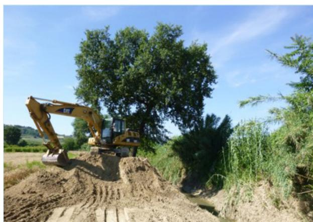
Figura 17 – Demolizioni degli argini sul torrente Pisciatello nel tratto collinare (Calise)
