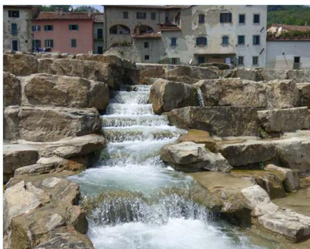
Figura 6–Passaggio per pesci del tipo a bacini successivi realizzata in occasione della ristrutturazione della “briglia ENEL” sul fiume Bidente, in località Santa Sofia (FC). A) La briglia prima della ristrutturazione. B) Scala di risalita al termine dei lavori
