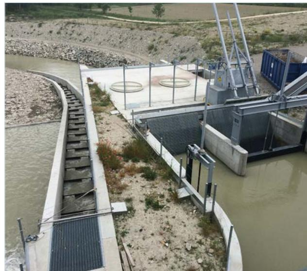
Figura 10 – Passaggio per pesci del tipo a bacini successivi sul fiume Savio, in località Ponte Matellica (Cervia - RA).
