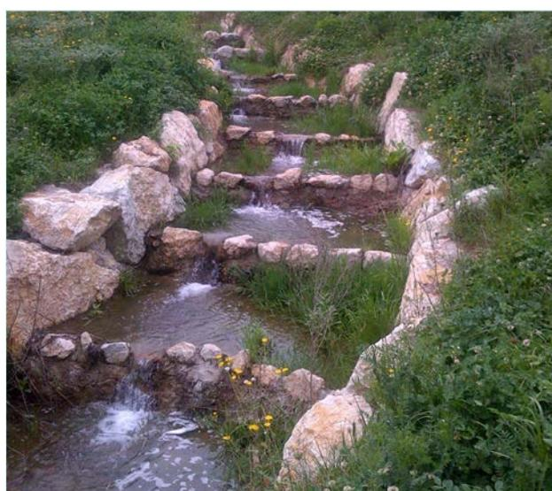
Figura 3 – Passaggio per pesci del tipo fish ramp (con boulder bars) con profilo a “pool and weir” realizzata sul fiume Montone, in località Villarovere. A) Scala di risalita in fase di costruzione (2011). B) Scala di risalita dopo 2 anni dalla realizzazione (2013)
