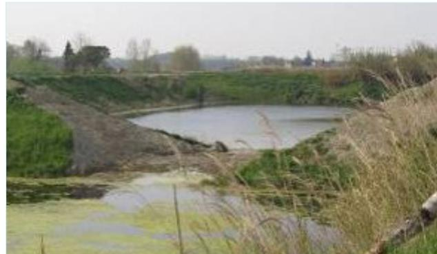
Figura 10 - Cassa di espansione SFIR- Realizzazione setti di collegamento vasche invasabili. Realizzazione 2016
