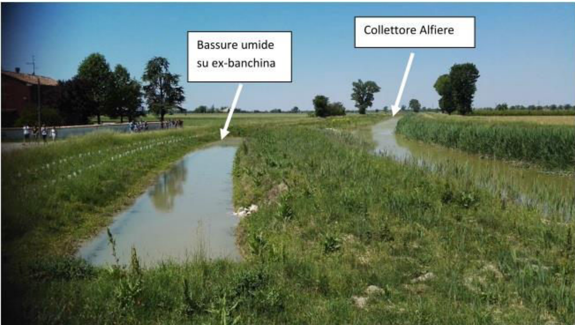
Collettore Alfieri e bassure umide a due anni dal termine dei lavori
