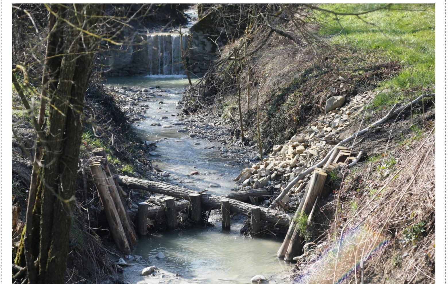
FOTO 2 – SALTO NATURALIFORME LUNGO IL RIO ENZOLA A MONTE DELL'ABITATO DI QUATTRO CASTELLA (RE)
