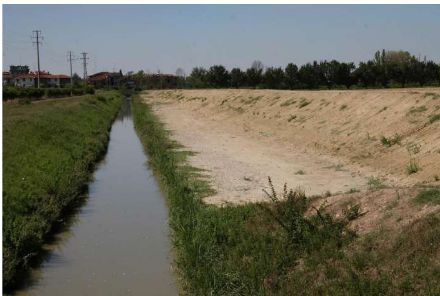
Diversivo Fossa Nuova Cavata al termine dei lavori di scavo (vista da valle verso monte)
