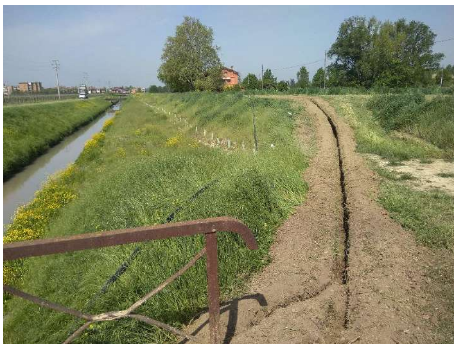
Diversivo Fossa Nuova Cavata dopo un anno dal termine dei lavori
