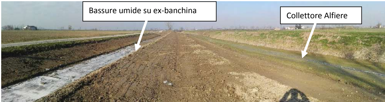
Collettore Alfieri e bassure umide al termine dei lavori di scavo (vista da valle verso monte)
