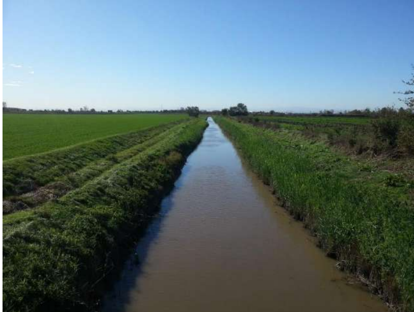
CABM prima dei lavori (vista da valle verso monte)
