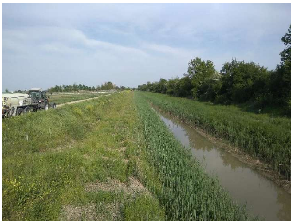
CABM dopo un anno dal termine dei lavori (a sinistra la golena ricreata)
