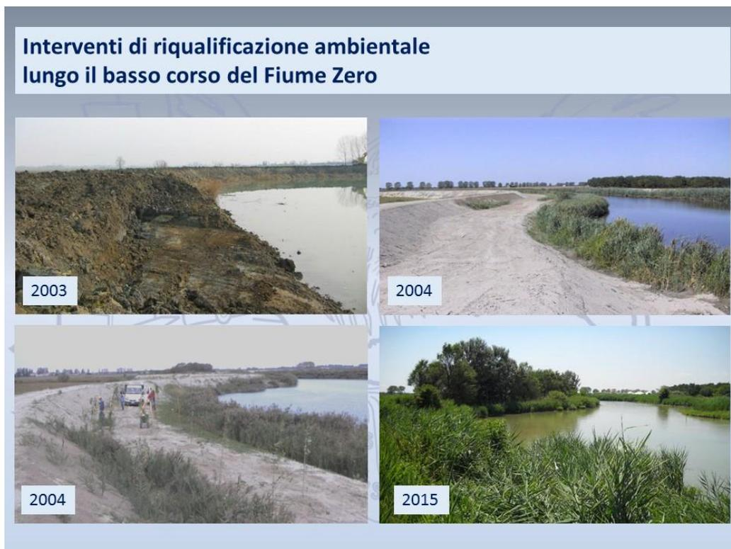
Figura 8 – Fiume Zero - Foto del corso d'acqua prima, durante i lavori e dopo l'intervento
