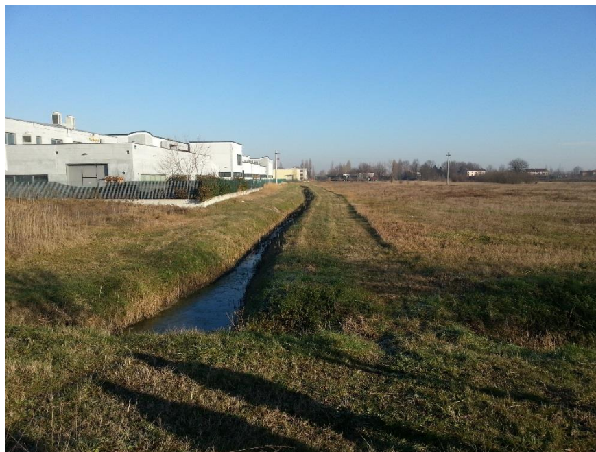
Figura – Tratto 1 di intervento sulla CAVATA ORIENTALE (vista da monte verso valle dal punto di origine del canale; in destra l'area di ampliamento)
