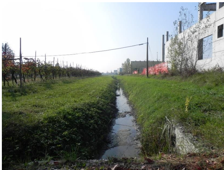
Figura – Tratto 3 di intervento sulla CAVATA ORIENTALE (vista da valle, dal ponte di via Lama, verso monte; a sinistra della foto si nota il vigneto che non verrà interessato dalle operazioni di allargamento del canale e che costituisce un vincolo progettuale che limita la possibilità di creare una banchina allagabile)
