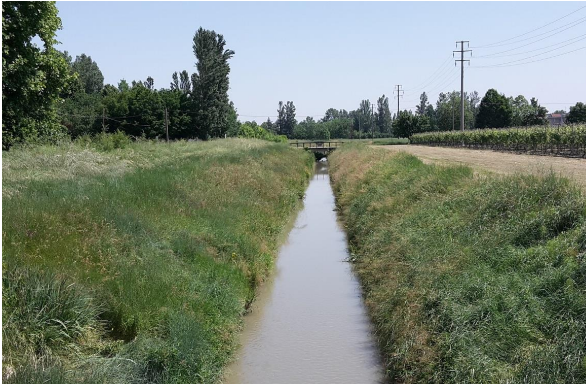
Figura 4 – vista dal ponte di via Pola esterna, verso valle.
