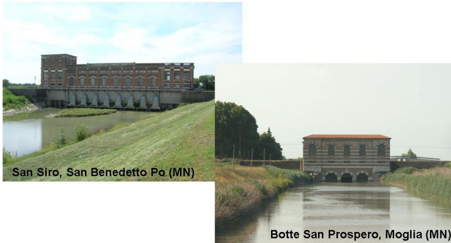
Figura 15 - Evitare l'accumulo di ramaglie agli impianti idrovori e ai manufatti del Consorzio (foto esemplificativa)
