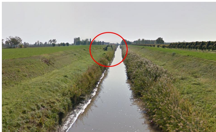
Figura 16 - Necessità di poter continuare ad eseguire la manutenzione dell'alveo
