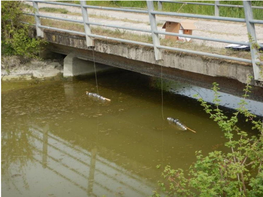
Figura 8 –Substrati artificiali (SA) a lamelle per la cattura dei macroinvertebrati lungo il COLLETTORE ALFIERE
