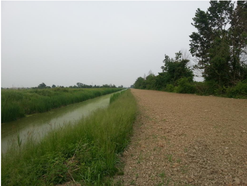
Figura 22 – Tratto 2 di intervento sul COLLETORE ALFIERE, vista verso valle (alveo a sinistra, banca esistente a destra)
