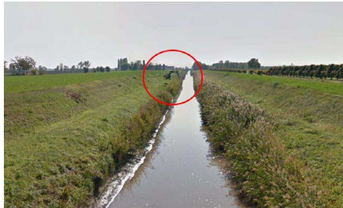
Figura 25 - Necessità di poter continuare ad eseguire la manutenzione dell'alveo
