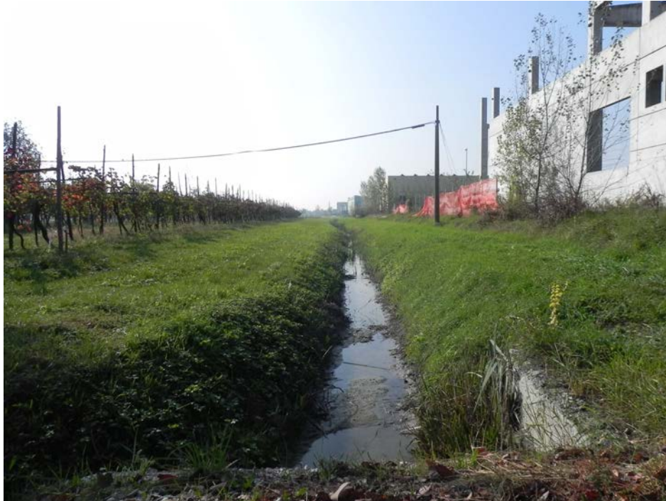
Figura 35 – Tratto 3 di intervento sulla CAVATA ORIENTALE (vista da valle, dal ponte di via Lama, verso monte; a sinistra della foto si nota il vigneto che non verrà interessato dalle operazioni di allargamento del canale e che costituisce un vincolo progettuale che limita la possibilità di creare una banchina allagabile)
