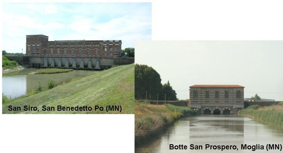
Figura 26 - Evitare l'accumulo di residui vegetali agli impianti idrovori e ai manufatti del Consorzio (foto esemplificativa)
