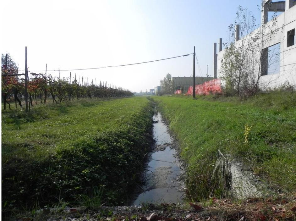
Figura 41 – Tratto 3 di intervento sulla CAVATA ORIENTALE (vista da valle, dal ponte di via Lama, verso monte; a sinistra della foto si nota il vigneto che non verrà interessato dalle operazioni di allargamento del canale e che costituisce un vincolo progettuale che limita la possibilità di creare una banchina allagabile)
