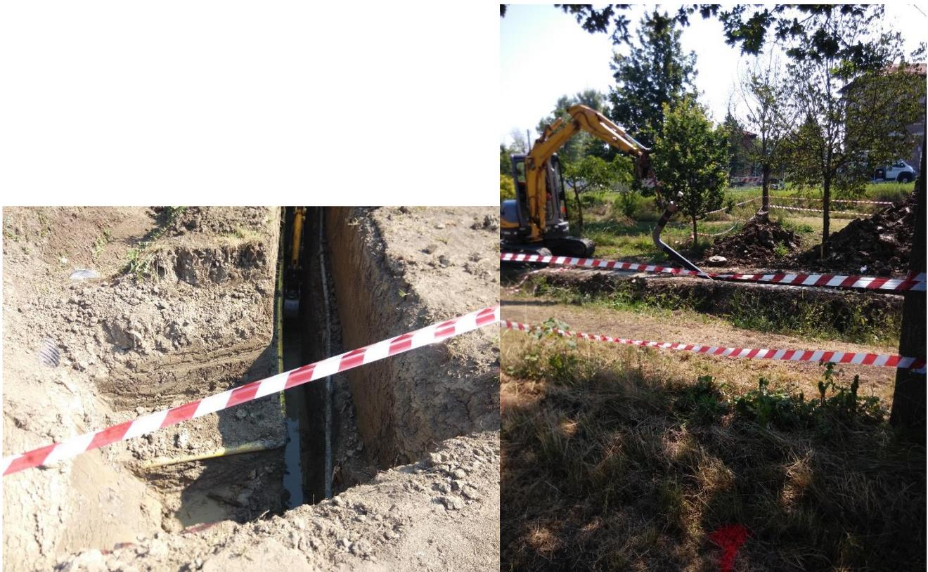
Figura 82 – Nella foto di sinistra si nota la tubazione del gas che deve essere portata a maggiore profondità, all'interno dello scavo appositamente predisposto a fianco. Nella foto di destra si nota il raccordo ad U della tubazione del gas che è stato posato per approfondire la tubazione del gas.
