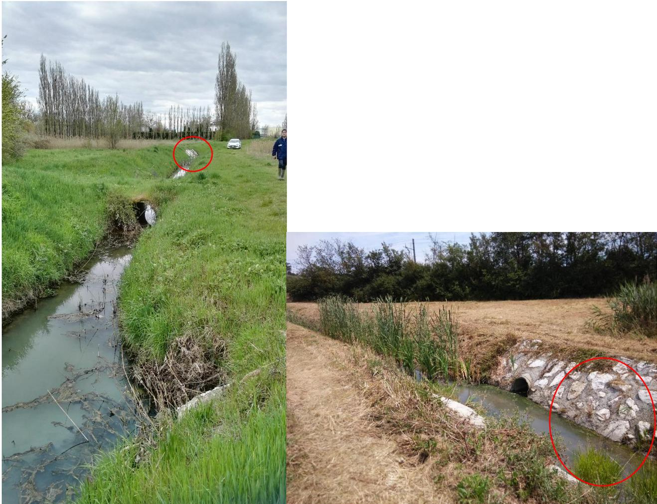
Figura 83 – Nelle foto si nota la protezione spondale e del fondo presente in corrispondenza del sottopasso della tubazione dell'acqua potabile lungo la Cavata Orientale.
