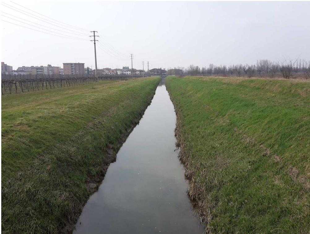
Figura 31 – Tratto di intervento sul DFNC
