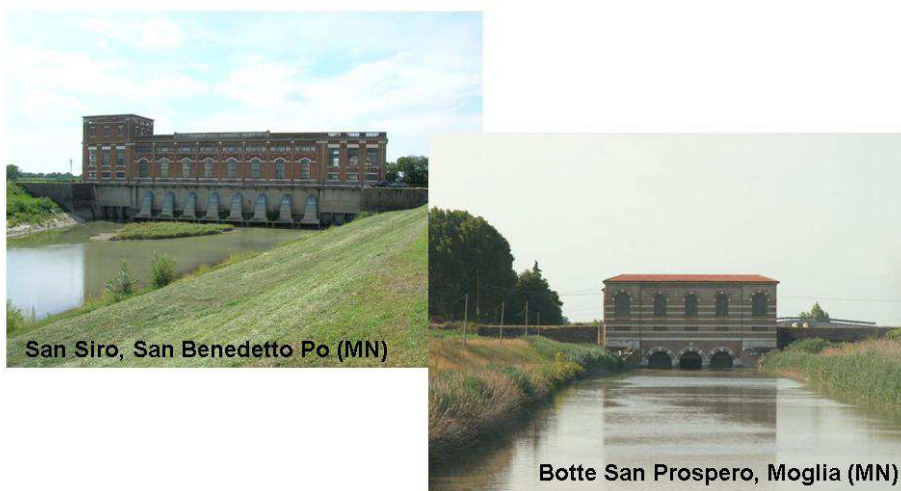
Figura 28 - Evitare l'accumulo di residui vegetali agli impianti idrovori e ai manufatti del Consorzio (foto esemplificativa)
