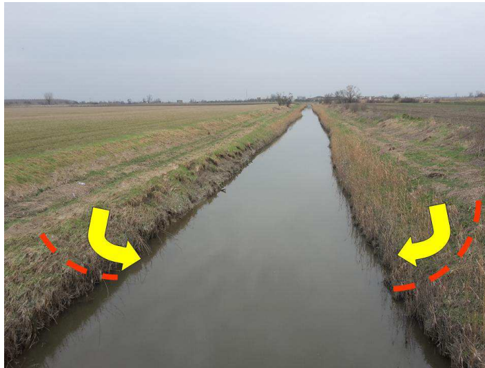
Figura 26 - Esempio della necessità di continuare a garantire la stabilità della sponda
