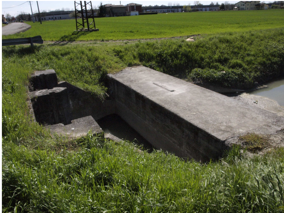
Figura 38: Ponte canale in chiusura del tratto di intervento.
