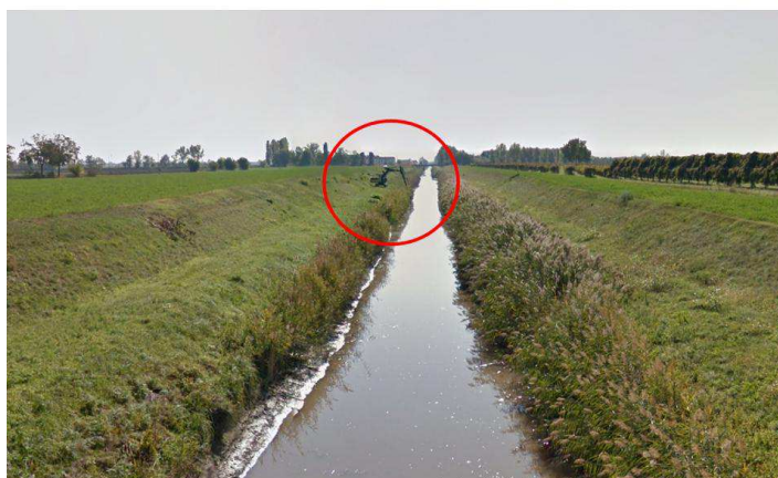
Figura 27 - Necessità di poter continuare ad eseguire la manutenzione dell'alveo
