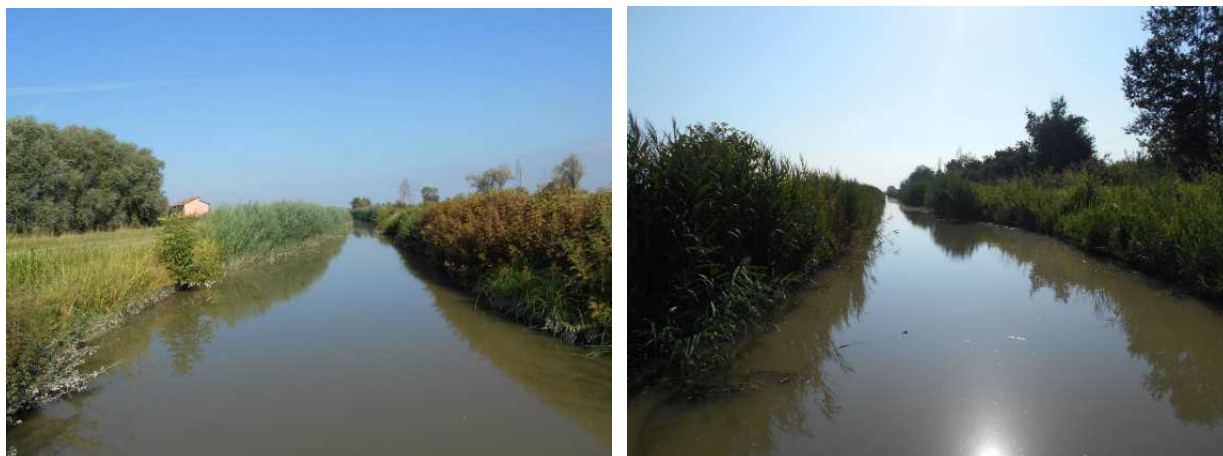
Figura 2 – Sezione di monte (a sinistra) e sezione di valle (a destra) oggetto di campionamento del primo tratto del Collettore Alfieri (CA).
