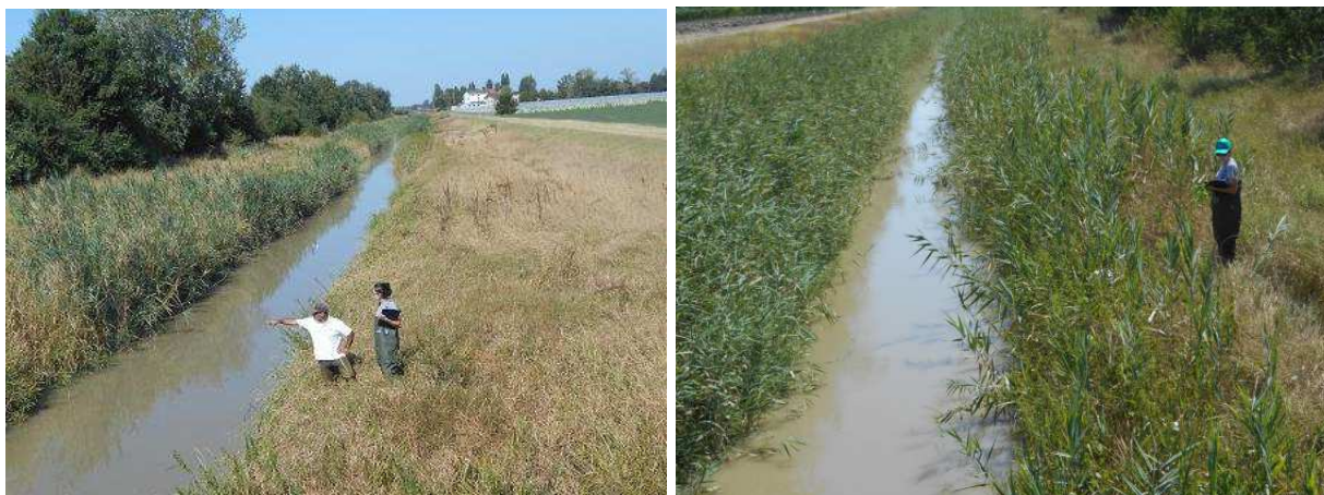
Figura 2 – Sezione di monte (a sinistra) e sezione di valle (a destra) oggetto di campionamento del primo tratto del Collettore Acque Basse Modenesi (CABM).
