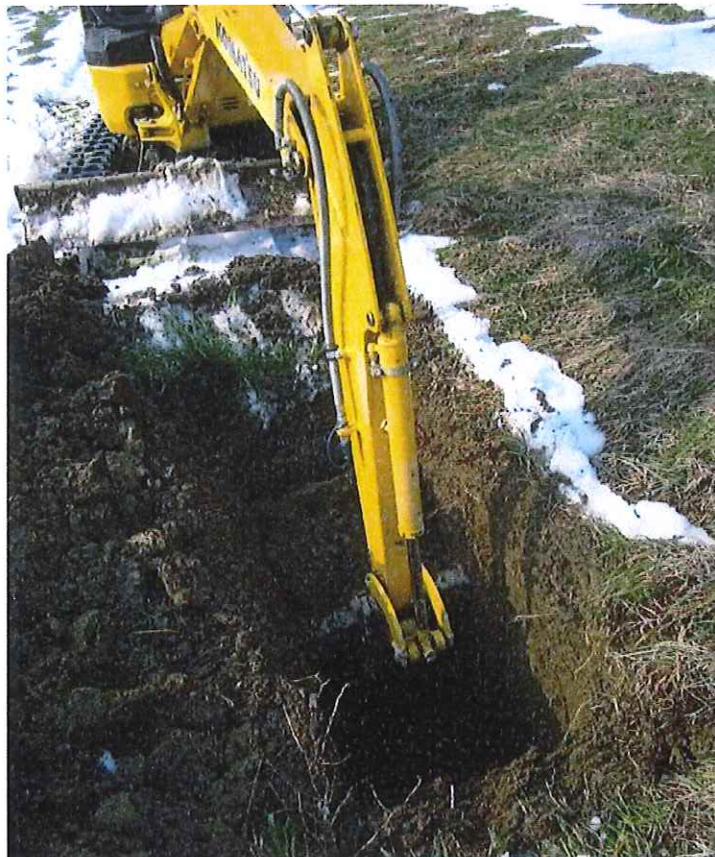
Foto attività di scavo – Diversivo Fossa Nuova Cavata
