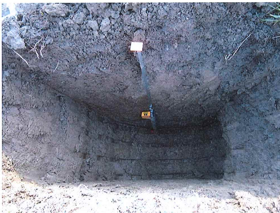
Foto Scavo 1 – Diversivo Fossa Nuova Cavata (sponda sinistra)
