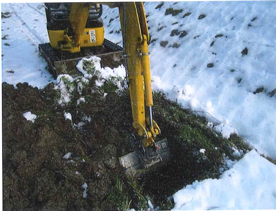
Foto attività di scavo – CABM Novi di Modena (sponda destra)
