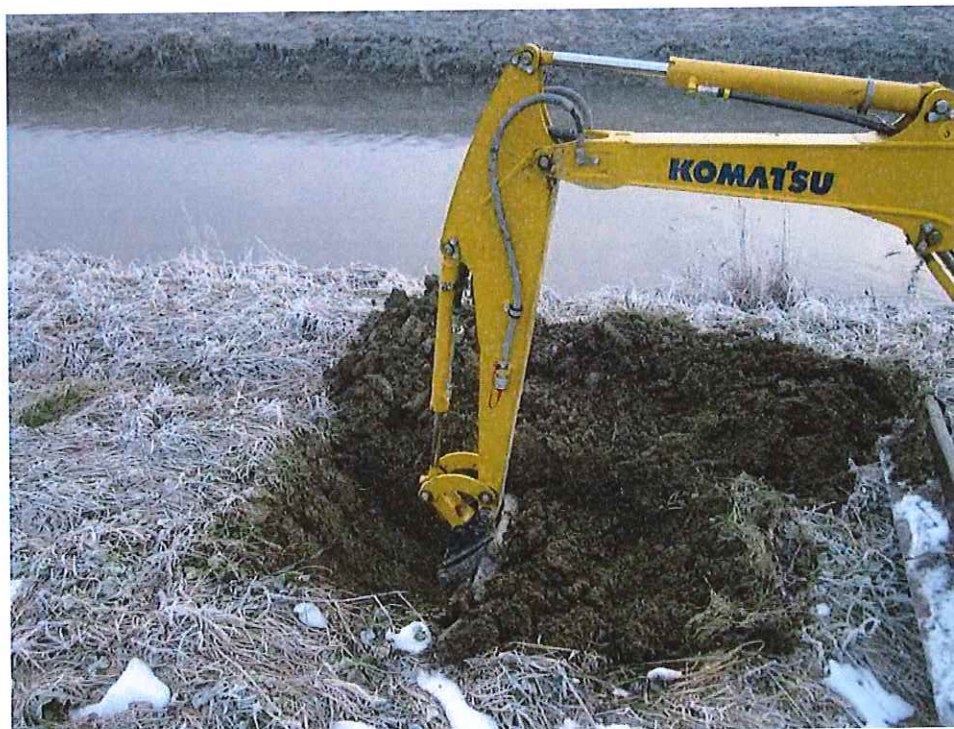
Foto attività di scavo – CABM Novi di Modena (sponda sinistra)
