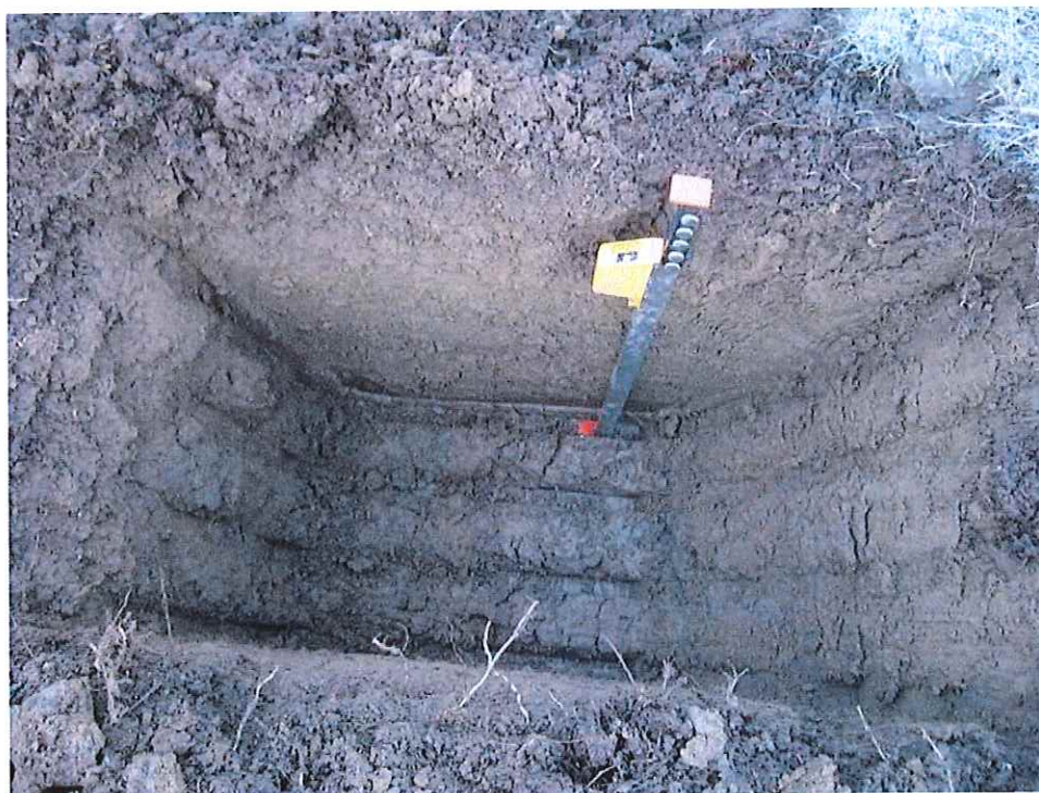
Foto scavo 1 – CABM Novi di Modena (sponda sinistra)
