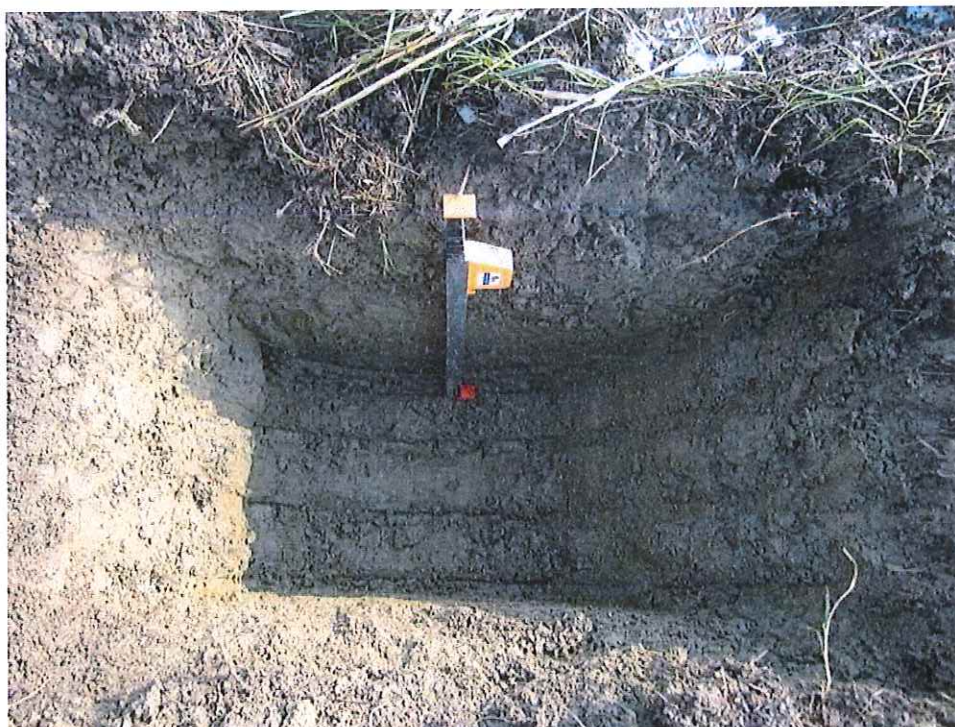
Foto scavo 1 – CABM Novi di Modena (sponda destra)
