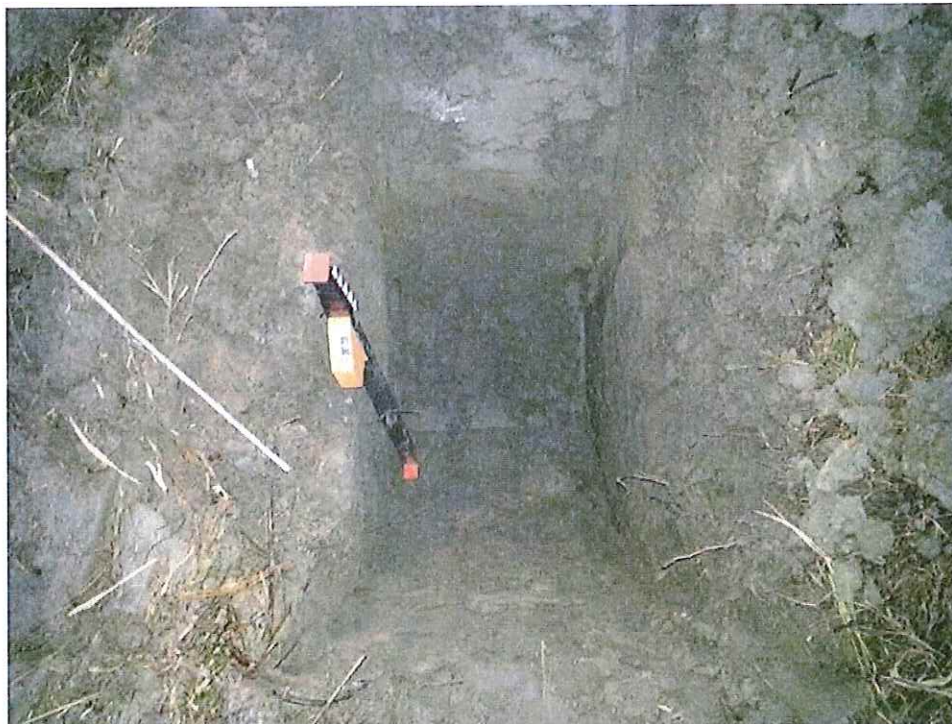
Foto Scavo 5 – CABM Carpi (sponda sinistra)
