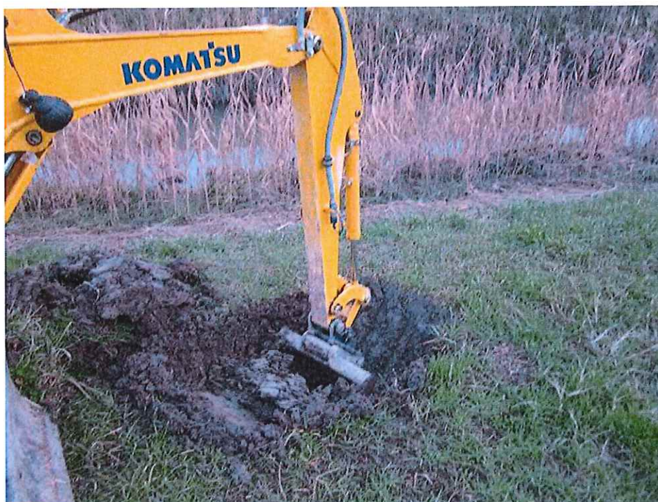
Foto attività di scavo – CABM Carpi (sponda sinistra)
