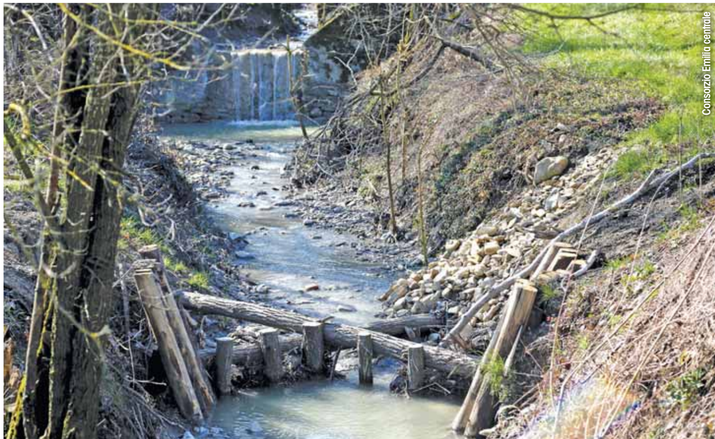
Un esempio di salto di fondo naturaliforme utilizzato per la riconnessione di lembi golenali all'alveo attuale
