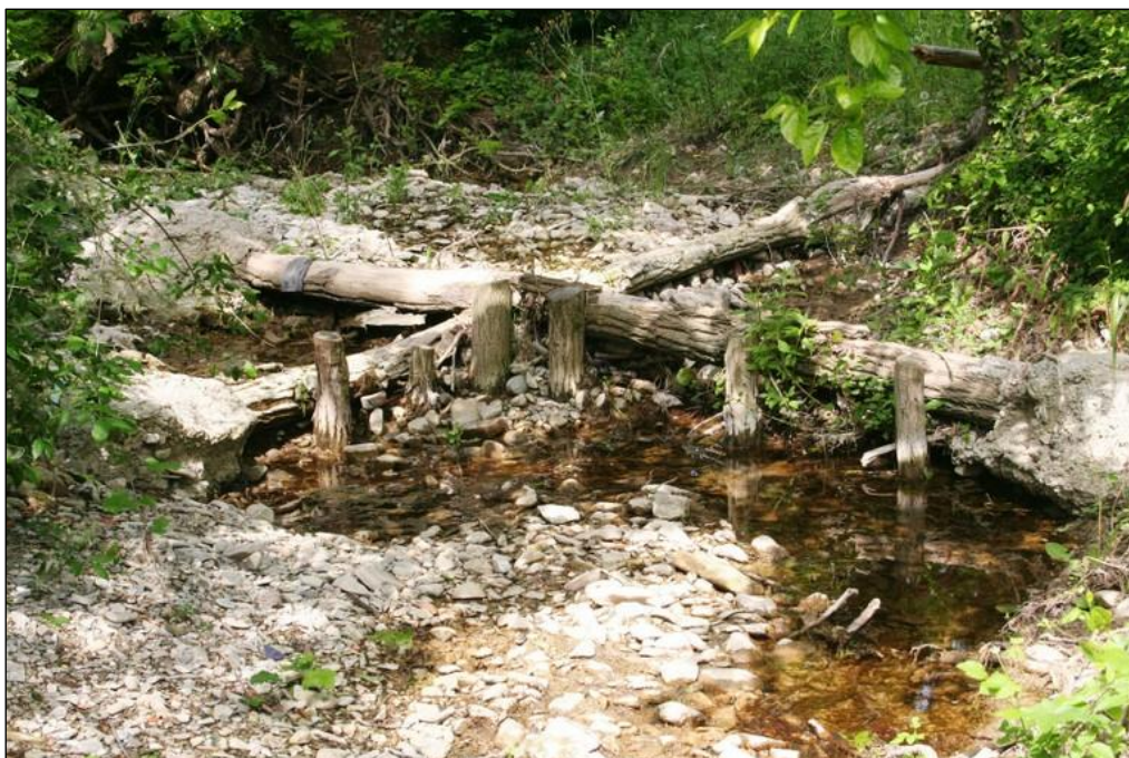
Figura 17 – Dettaglio di una soglia naturaliforme lungo il Rio Lavezza nella primavera 2016: sotto la struttura sono visibili delle buche che ospitano pozze d'acqua, mentre a monte è visibile l'accumulo dei sedimenti che generano un rialzo localizzato dell'alveo.
