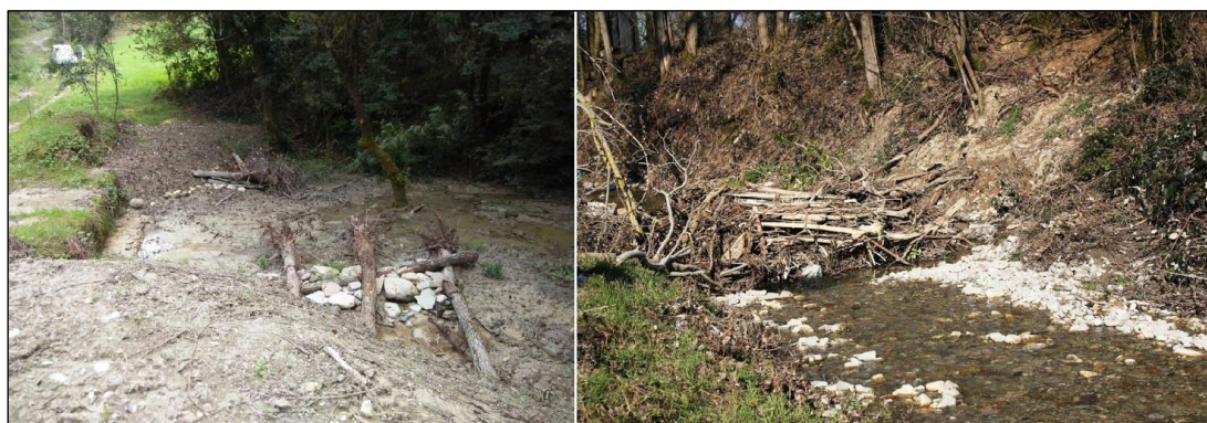
Figura 22 – A sinistra: un deflettore di corrente in pietrame e legname appena terminato sul Rio Bertolini. A destra: un deflettore sul Rio Lavezza nella primavera 2015. È visibile un accumulo di legname e detriti che copre quasi completamente la struttura.
