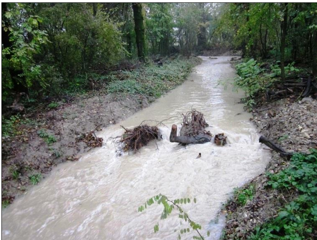
Figura 14 – Un salto naturaliforme realizzato sul Rio Arianna durante le piene del novembre 2014.
