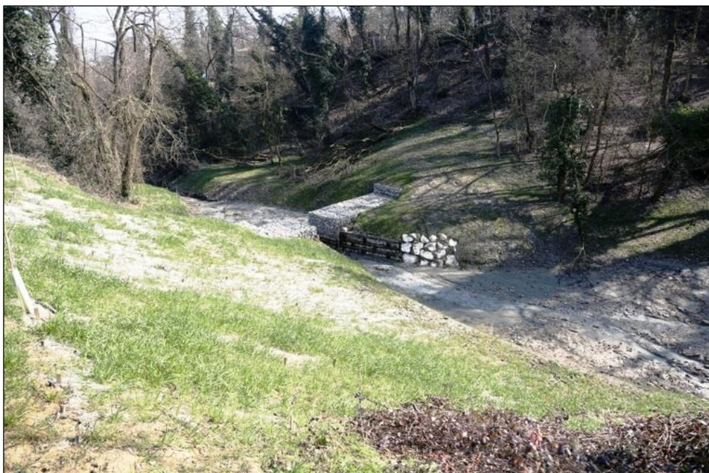
Figura 10 – Il restringimento in pietrame rinverdito realizzato sul Rio Bianello nel marzo 2015.
