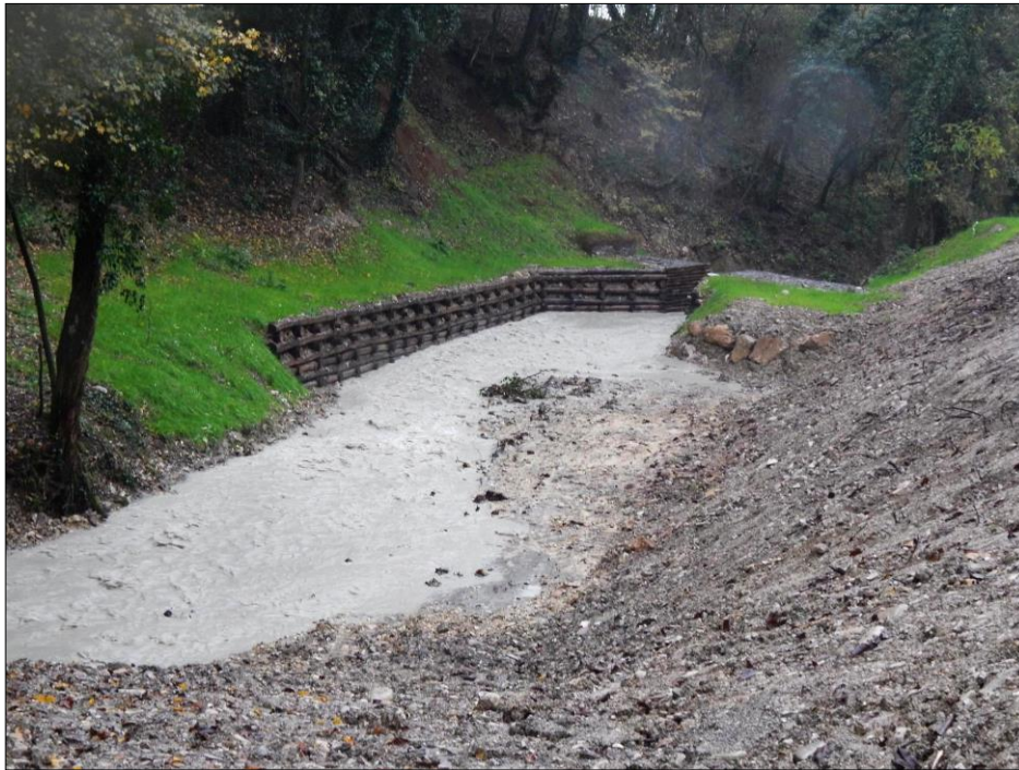
Figura 6 – L'invaso delle acque a monte del restringimento in pietrame rinverdito realizzato sul rio Enzola durante la piena del 10/11/2014.
