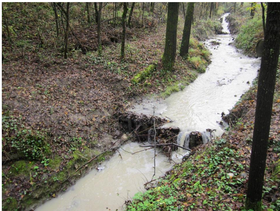
Figura 28 – Il salto di fondo naturaliforme durante le piogge fine ottobre 2014. Notare l'accumulo di materiale e l'invaso delle acque sul lato di monte in corrispondenza di una piccola golen.
