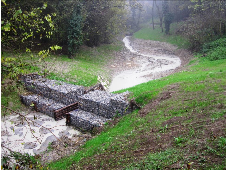
Figura 9 – Il restringimento in pietrame rinverdito realizzato sul Rio Bianello durante le piogge di fine ottobre 2014. Si può notare l'effetto di invaso delle acque a monte della struttura.
