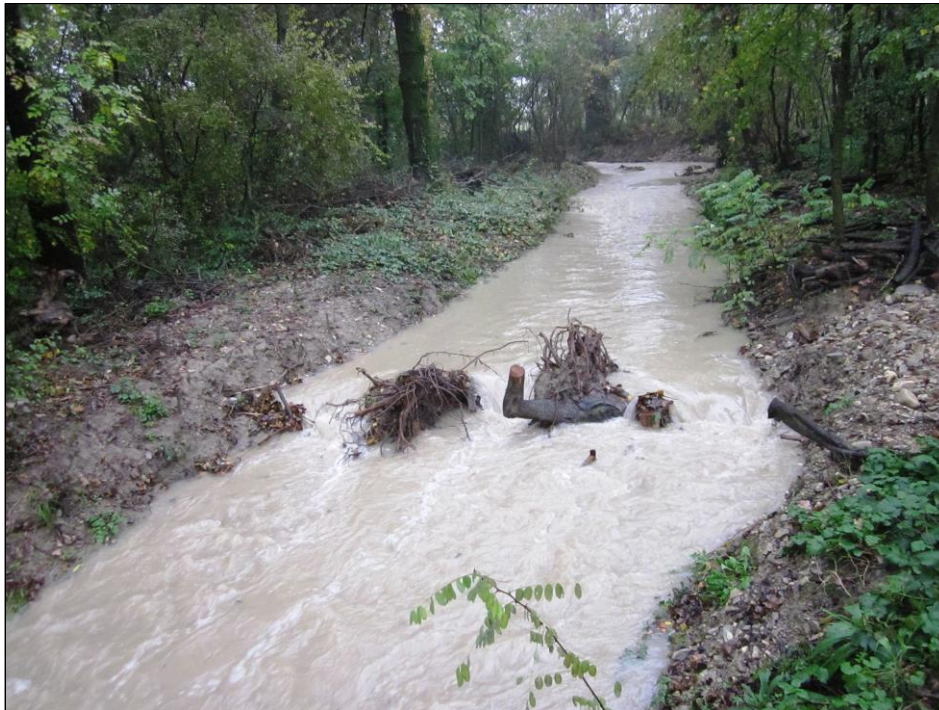
Figura 22 –L’effetto di un salto di fondo naturaliforme a radici esposte realizzato sul Rio Arianna. Si nota l’invaso a monte delle acque e l’effetto di locale deviazione della corrente.
