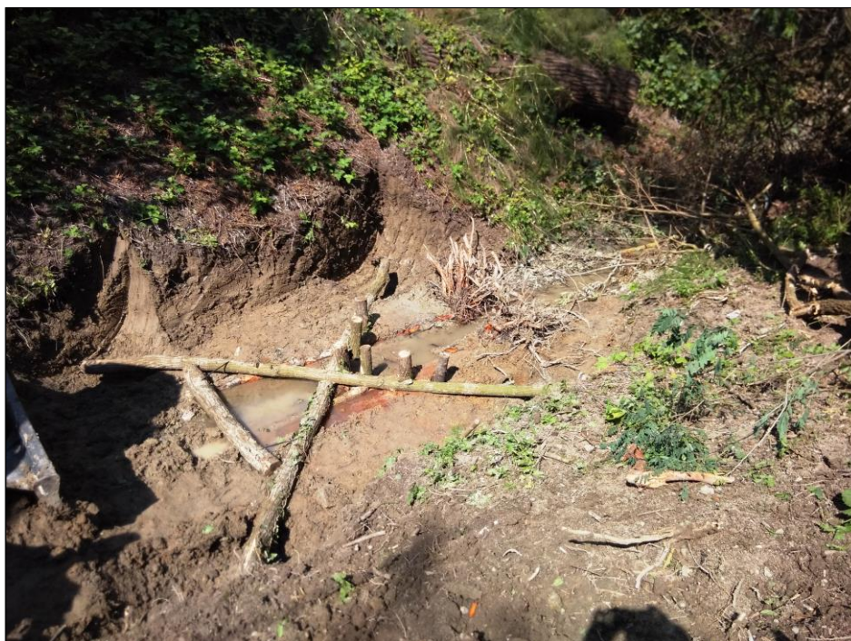
Figura 26 – Fase di realizzazione di un salto di fondo naturaliforme con radici esposte nell'alveo del Rio Bottazzo.
