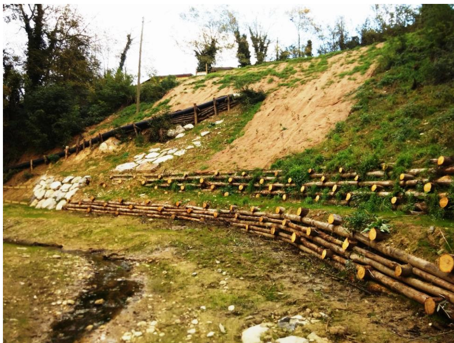
Figura 20 – Vista d'insieme della palificata realizzata sul Rio Arianna al termine del cantiere.
