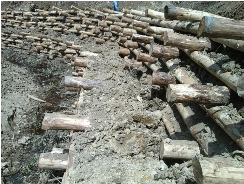
Figura 19 – Particolare costruttivo della palificata realizzata sul Rio Arianna durante il cantiere.
