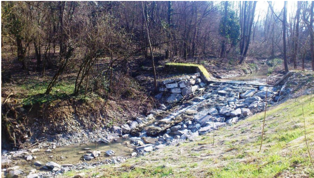
Figura 15 – La rampa in pietrame sulla briglia esistente al termine dei lavori.
