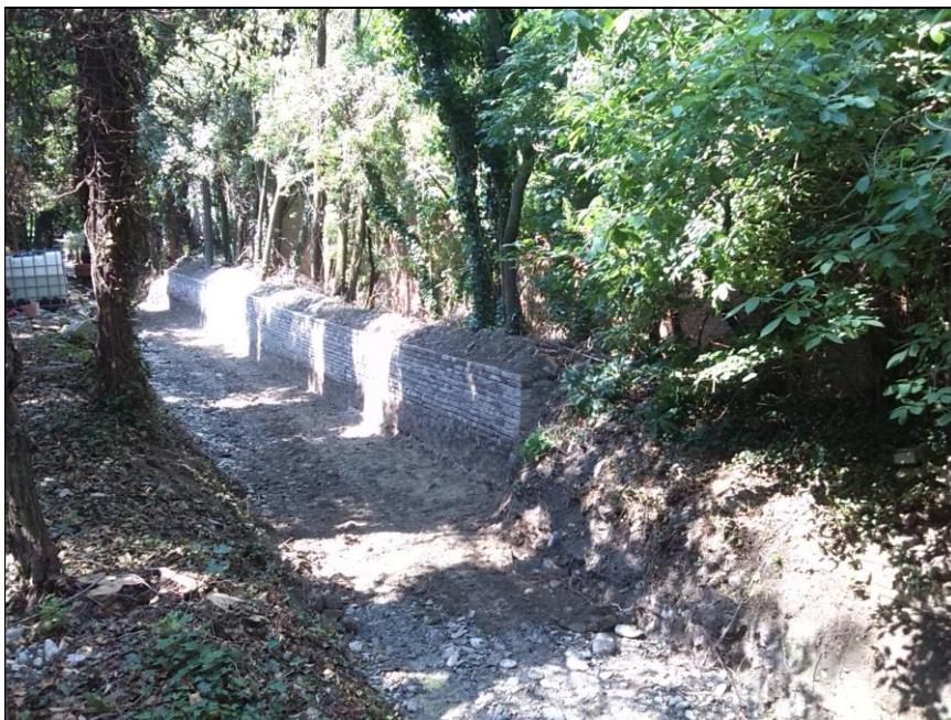
Figura 4 – Immagine del tratto pensile del Rio Enzola dopo i lavori di riqualificazione.
