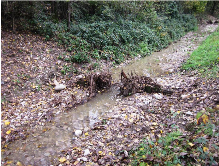
Figura 17 – Un salto di fondo naturaliforme realizzato sul Rio Lavezza durante le piogge di fine ottobre 2014. Notare l'accumulo di materiale sul lato di monte.
