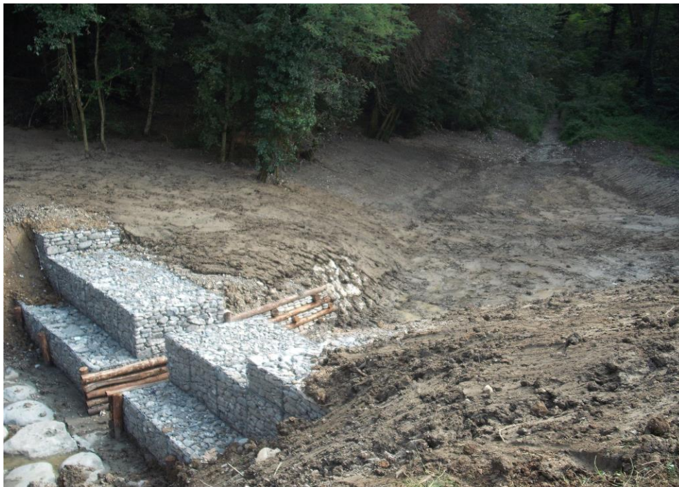
Figura 8 – Vista del Rio Bianello durante la posa in opera del restringimento in pietrame e la risagomatura dell'alveo retrostante.
