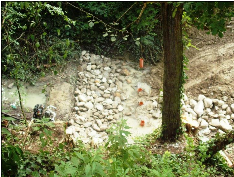
Figura 23 – Una fase della costruzione della rampa di risalita sul Rio Bertolini.
