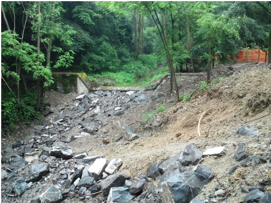
Figura 14 – Posa in opera della rampa in pietrame sulla briglia esistente.
