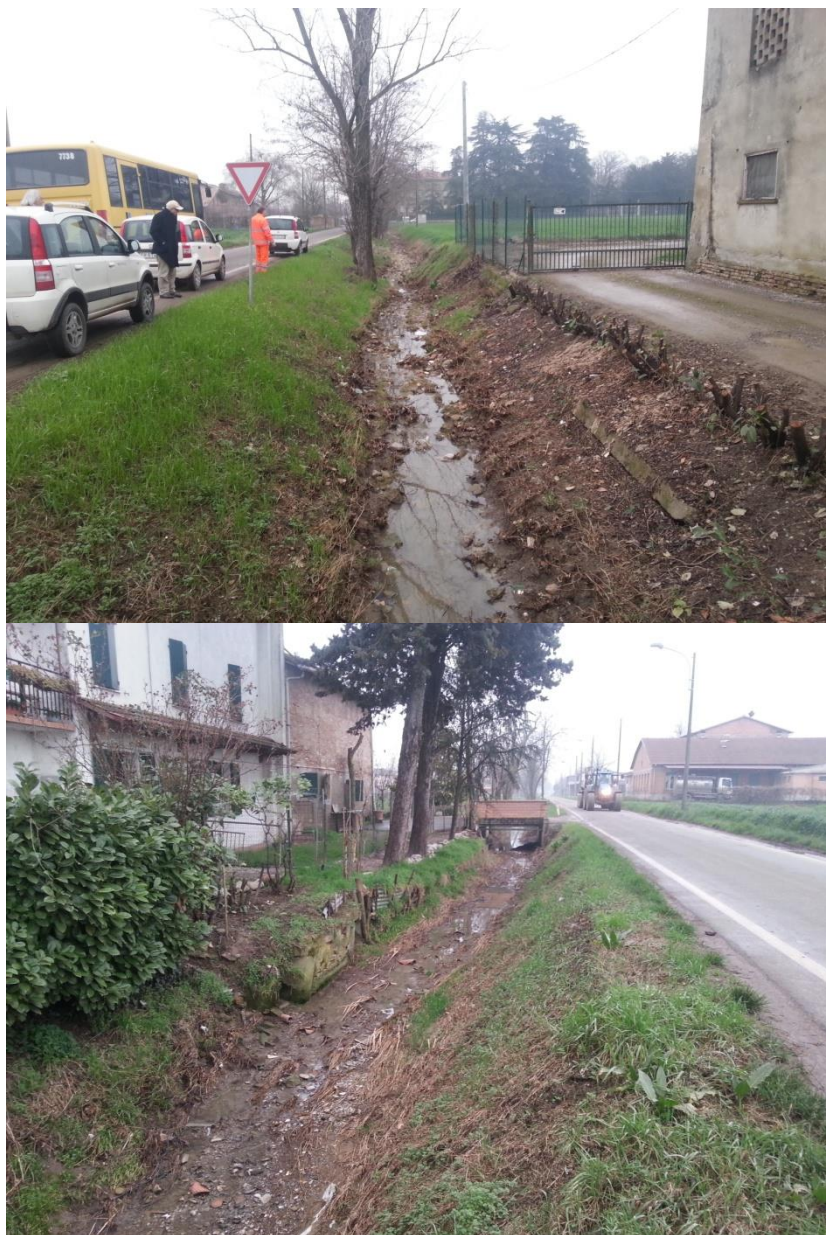
Figura 92 - Punto critico 3 del Rio Montefalcone. Vista verso valle (sopra) e verso monte (sotto) della situazione di degrado e dissesto della sponda destra.
