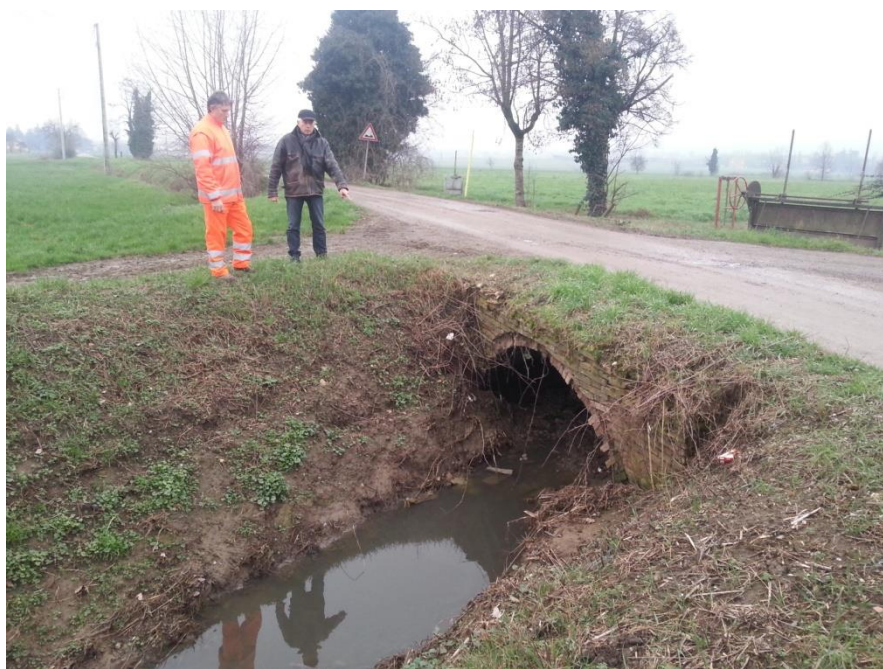
Figura 87 - Punto critico 3 del Rio Montefalcone. Ponte di attraversamento del rio e strada che ha costituito nel recente passato la via di deflusso principale delle piene verso Corniano.
