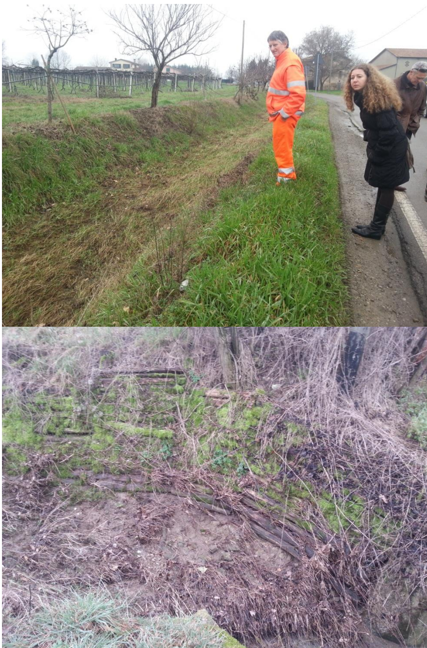
Figura 82 – Punto critico 2 del Rio Montefalcone - Tratto risagomato a valle del tratto tombinato di Piazzola: in basso, particolare della palificata ammalorata.
