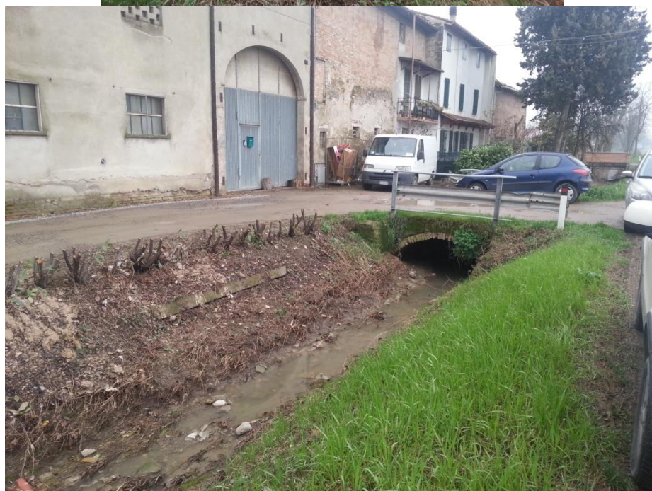
Figura 91 - Punto critico 3 del Rio Montefalcone. Vista verso valle (sopra) e verso monte (sotto) del ponte con luce insufficiente.
