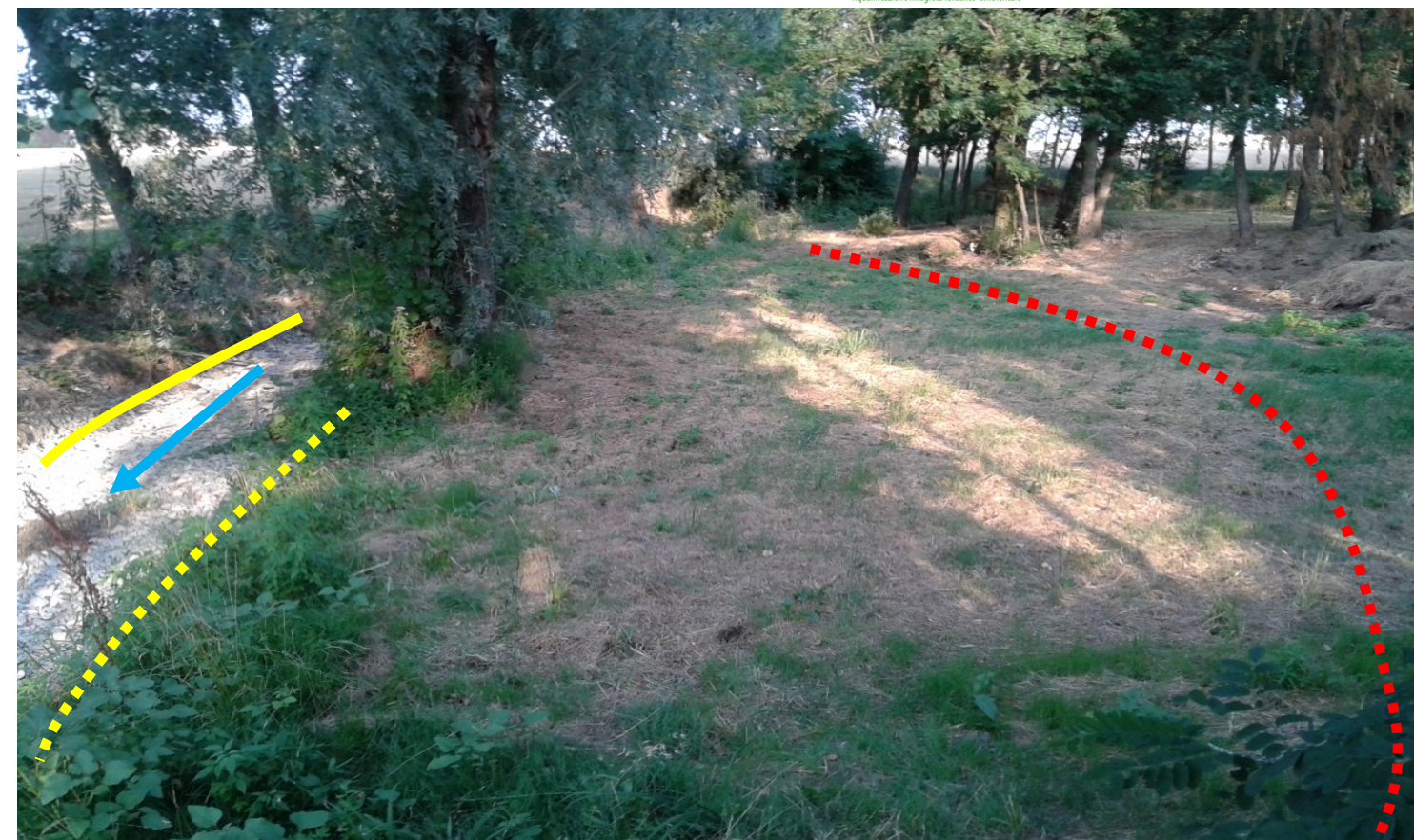
Sito di intervento ANTE OPERAM (15/07/2013) (vista da valle verso monte). In giallo continuo la sponda destra, in giallo tratteggiato la sponda sinistra pre intervento, in rosso la sponda sinistra dopo l'allargamento di sezione
