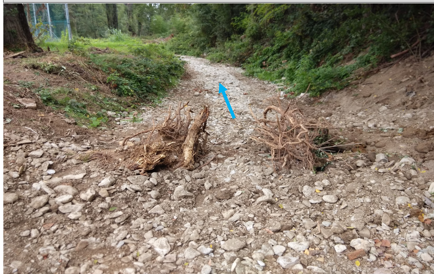
Rio Lavezza—SITO DI INTERVENTO AL TERMINE DEI LAVORI di posizionamento di TRONCHI CON RADICI ESPOSTE (05/09/2014)
