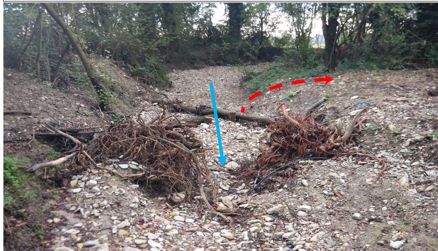
Rio Lavezza—Segmento 3e— Al termine dei lavori di posizionamento di SALTO DI FONDO CON RADICI ESPOSTE (16/10/2014). In ROSSO: andamento delle portate di piena verso la piana inondabile, riconnessa grazie all'innalzamento locale del fondo conseguente alla sistemazione in alveo dei tronchi
