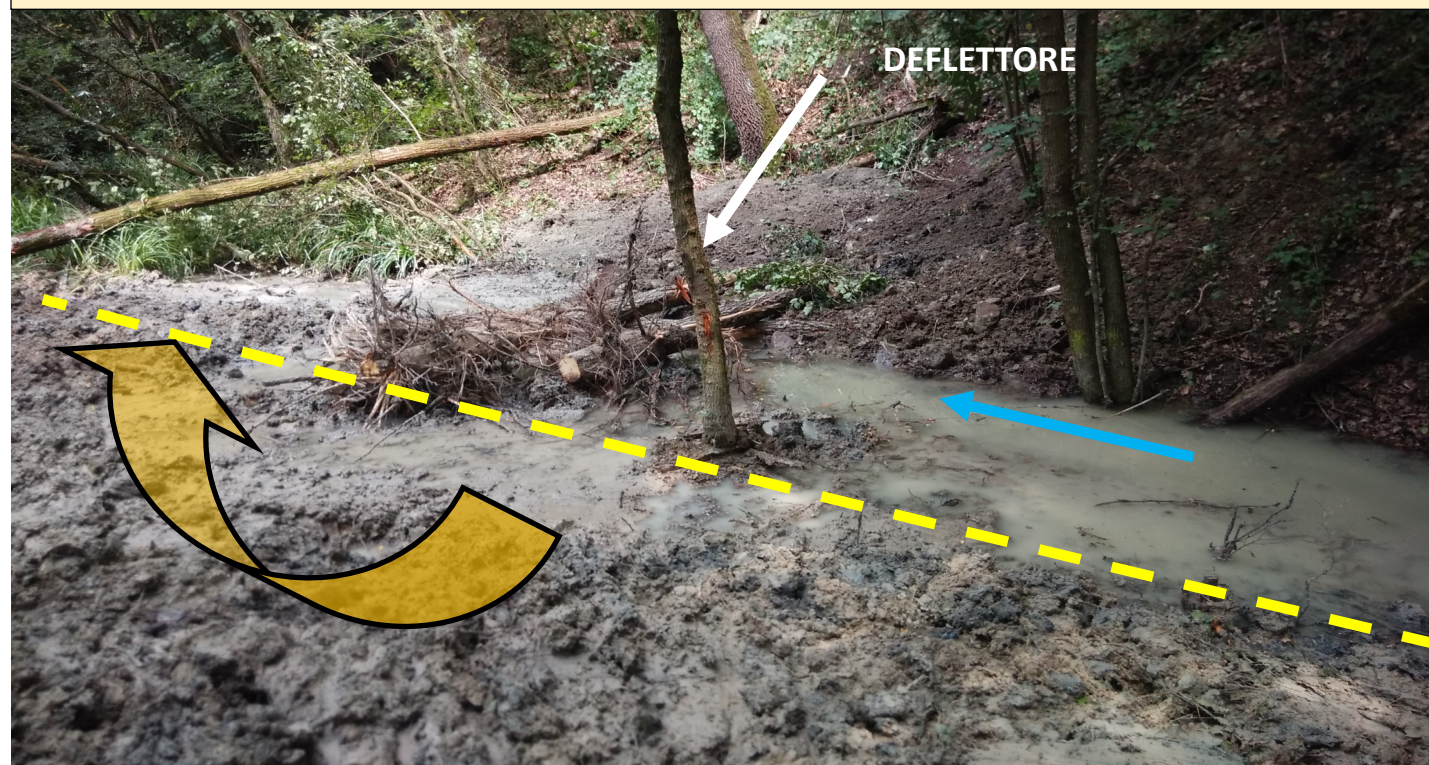
Rio Bertolini—Situazione successiva all'intervento di posizionamento del DEFLETTORE IN TRONCHI (21/08/2014) . In giallo la sponda sinistra dell'alveo pre-intervento. In arancione la corrente deviata dall'intervento, con l'interessamento della piana inondabile.
