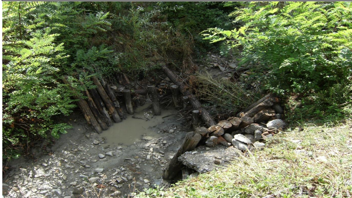
22 – Salto di fondo naturaliforme (trinci incrociati) (18/08/2015)
