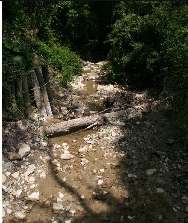
16-21 – Salto di fondo naturaliforme (trinci incrociati) (29/04/2016)
