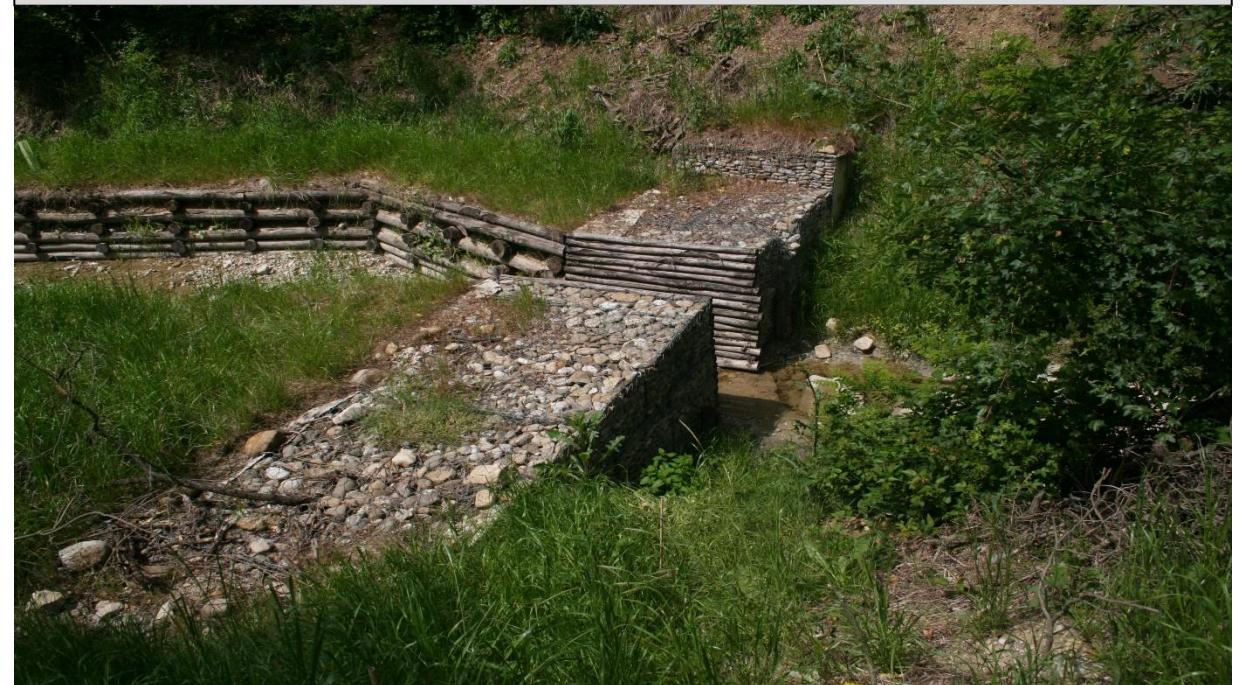
15 – Restringimento di sezione in massi a bocca tarata (29/04/2016)
