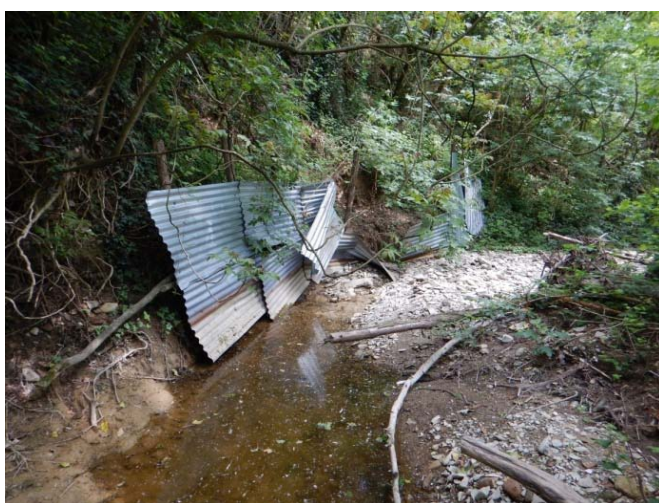
Figura 24 – Difese spondali improvvisate a tutela delle proprietà confinanti
