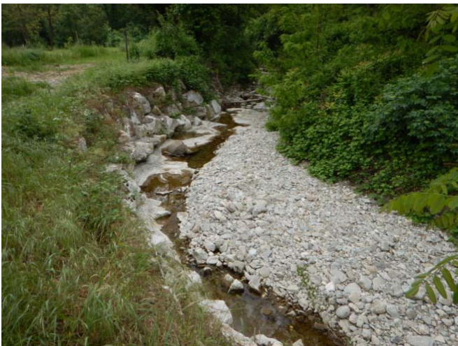
Figura 7 – Opere di contenimento laterali in massi cementati
