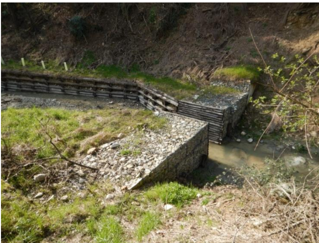
Figura 12 - Restringimento in pietrame e consolidamento della sponda
