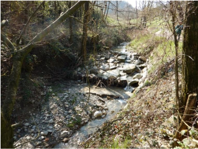
Figura 18 - Massi su briglia esistente a inizio tratto
