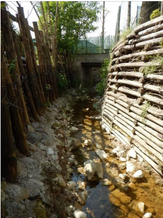
Figura 19: Morfologia dell'alveo, stretto tra opere di contenimento artificiale
