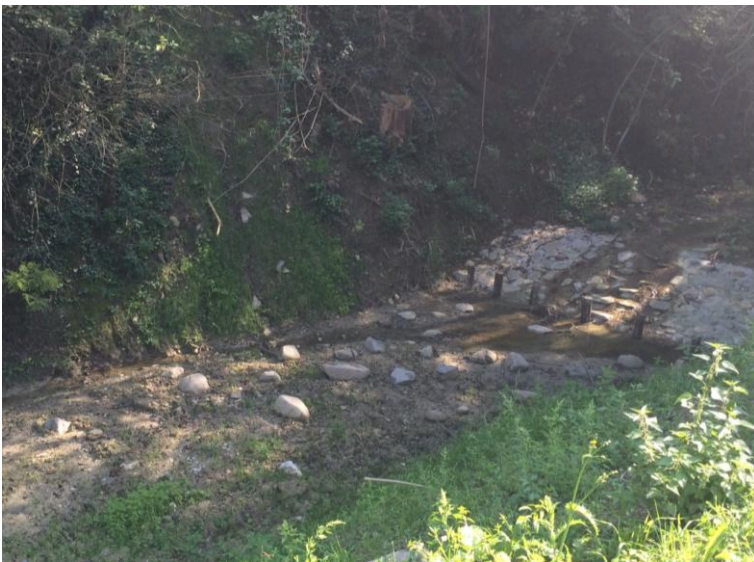
Figura 20: Rampa in massi su briglia esistente
