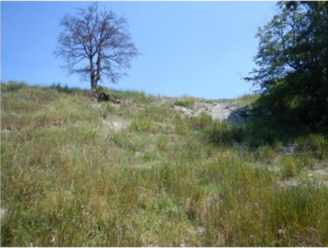
Figura 6: Zona di frana rilevata in ante operam
