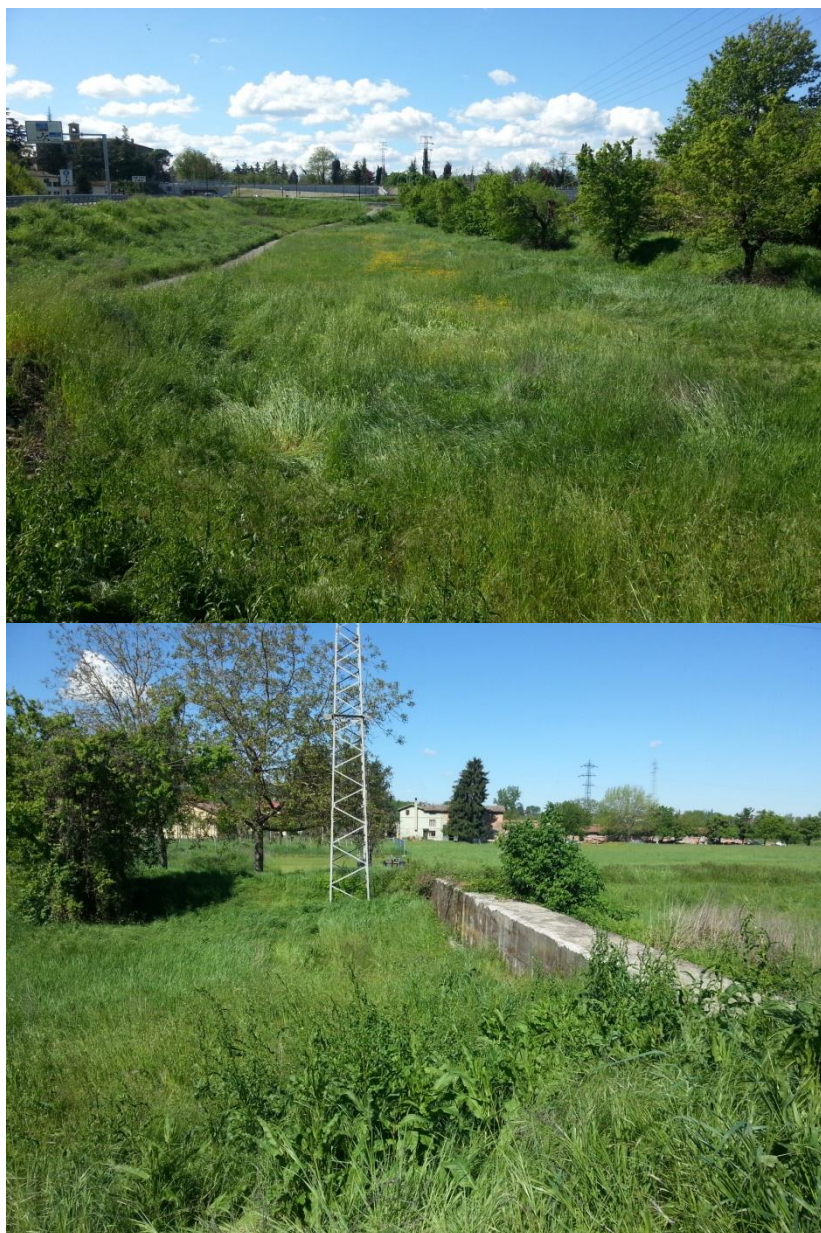
Figura 117 - Punto critico 1 del Rio Bertolini. Vista verso monte del tratto arginato pensile (a destra nella foto in alto) e del rilevato stradale (a sinistra e in alto nella medesima foto); vista del muro che interseca il tratto pensile (foto in basso). La situazione di pericolosità idraulica del Rio Bertolini nel tratto di interesse può essere affrontata tramite la realizzazione di un'area per l'esondazione delle piene (Figura 118) da posizionarsi a ridosso del tratto arginato, in una bassura del terreno già ora quasi completamente contornata dall'argine del rio, dal rilevato stradale su due lati e da un muro che incorpora una tubazione fognaria nel quarto lato. In questo caso l'intervento porterà benefici ecologici medi e non direttamente associati al corso d'acqua, quanto piuttosto all'area adibita alla laminazione delle piene, che potrà essere opportunamente riqualificata dal punto di vista naturalistico.
