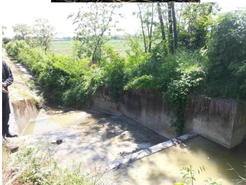
Figura 112 - Punto critico 1 del Rio Enzola. Vista del Rio Enzola verso monte, prima dell'imbocco nel tratto tombinato (in alto) e vista della parte iniziale dello scolmatore (in basso).
