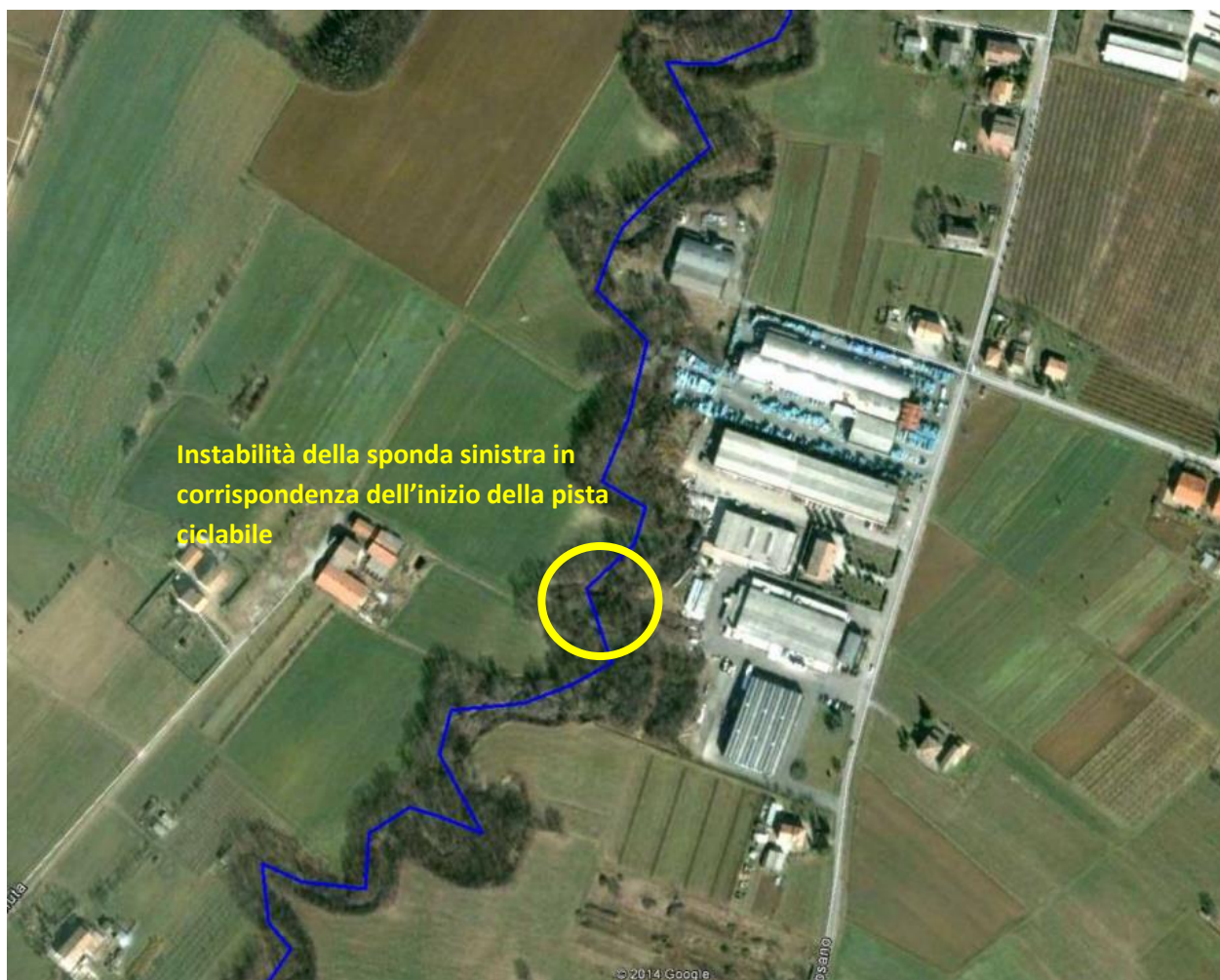
Figura 3 – Punto critico 1 del Torrente Lavezza – Versante in sinistra idraulica instabile.
