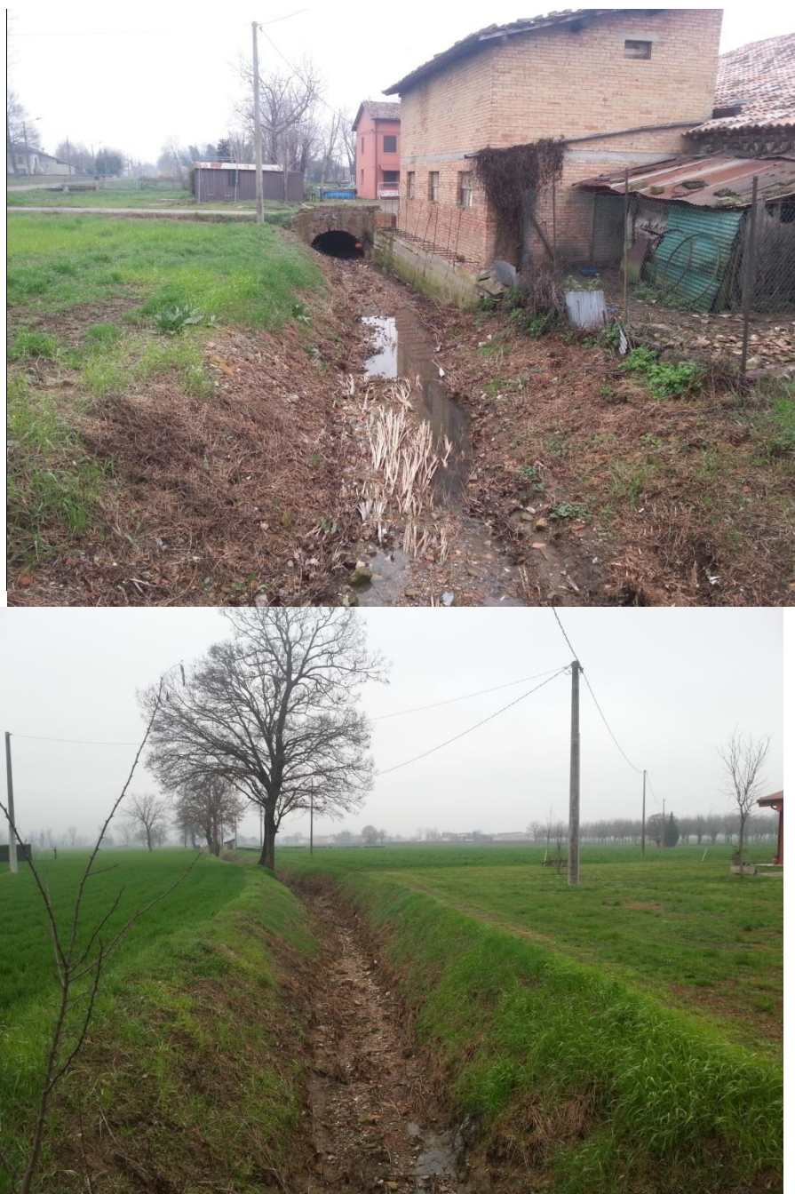
Figura 89 – Punto critico 3 del Rio Montefalcone. Vista verso valle (sopra) e del ponte con luce insufficiente, e verso monte (sotto).
