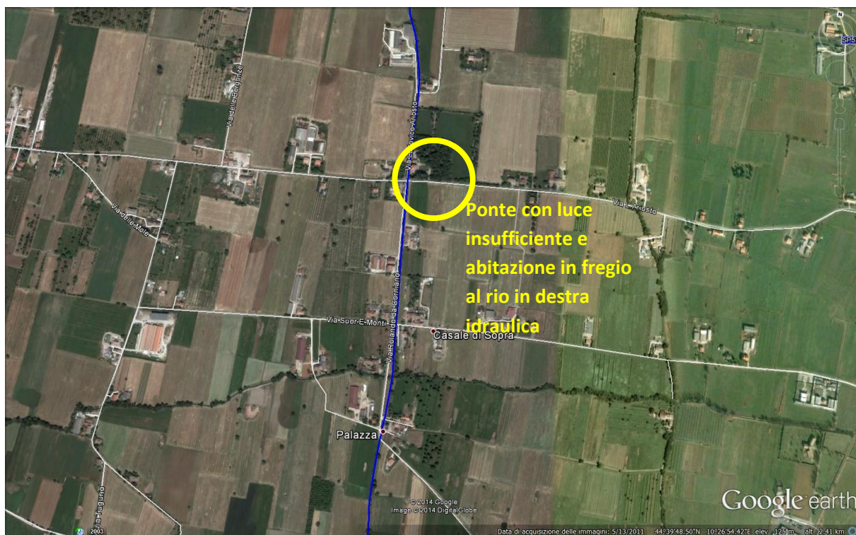
Figura 93 - Punto critico 3 del Rio Montefalcone.
