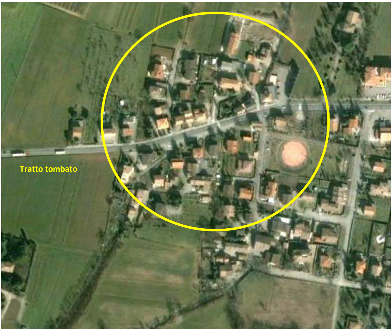
Figura 59 – Punto critico 1 del Rio Formica – Tratto tombato.
