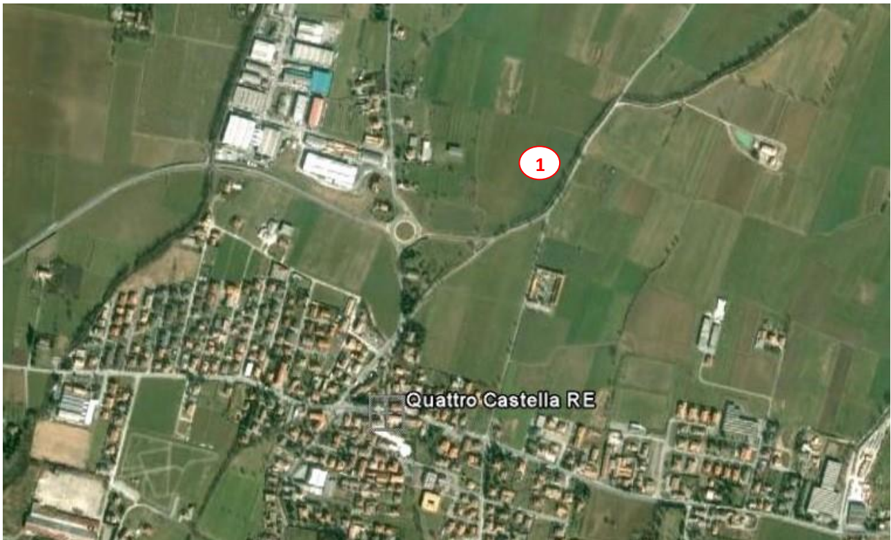
Figura 64 – Torrente Quaresimo – Punti critici in cui sono segnalate problematiche idrauliche e idromorfologiche.
