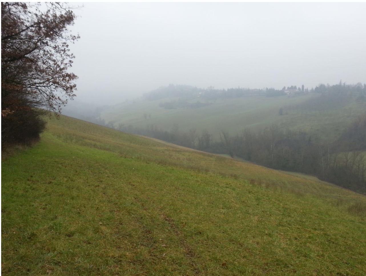
Figura 8 – Punto critico 2 del Torrente Lavezza - Frana attiva in destra idrografica in corrispondenza di una strada presente in sommità. La frana attiva che interessa il versante in destra idrografica del Torrente Lavezza mette a rischio una strada e delle abitazioni e può essere controllata intervenendo sia sul versante stesso (azione non oggetto del presente lavoro) sia sul corso d'acqua.
