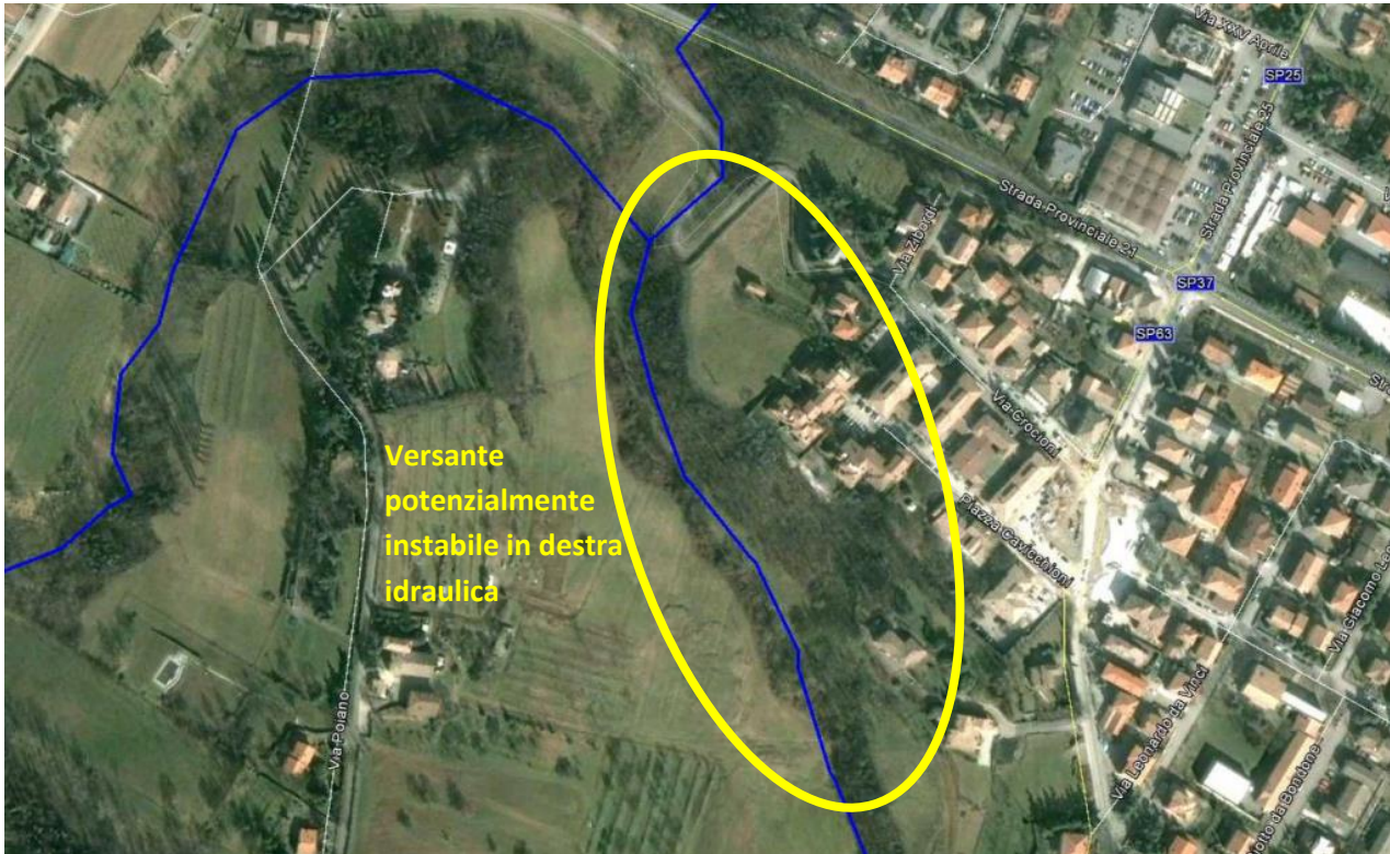
Figura 31 - Punto critico 4 del Rio Poiano. Versante potenzialmente instabile in destra idraulica.
