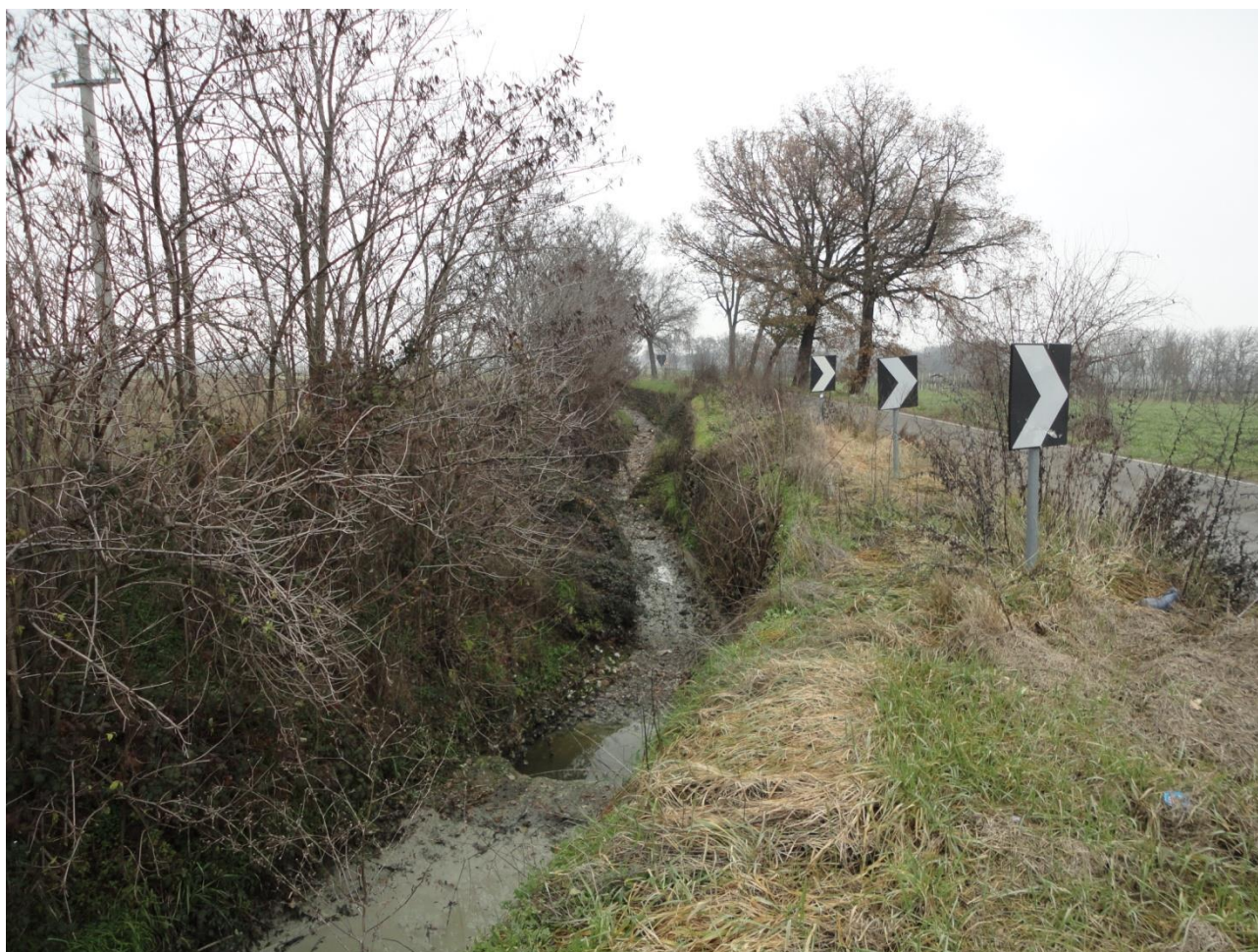
Figura 67 – Punto critico 1 del Torrente Quaresimo a valle del tratto tombinato.
