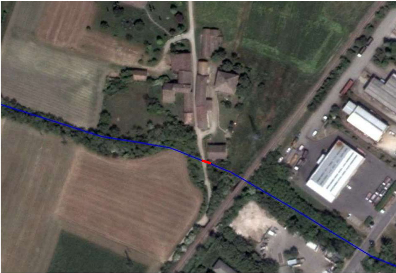
Figura 73 - Rifacimento del guado (in rosso).
