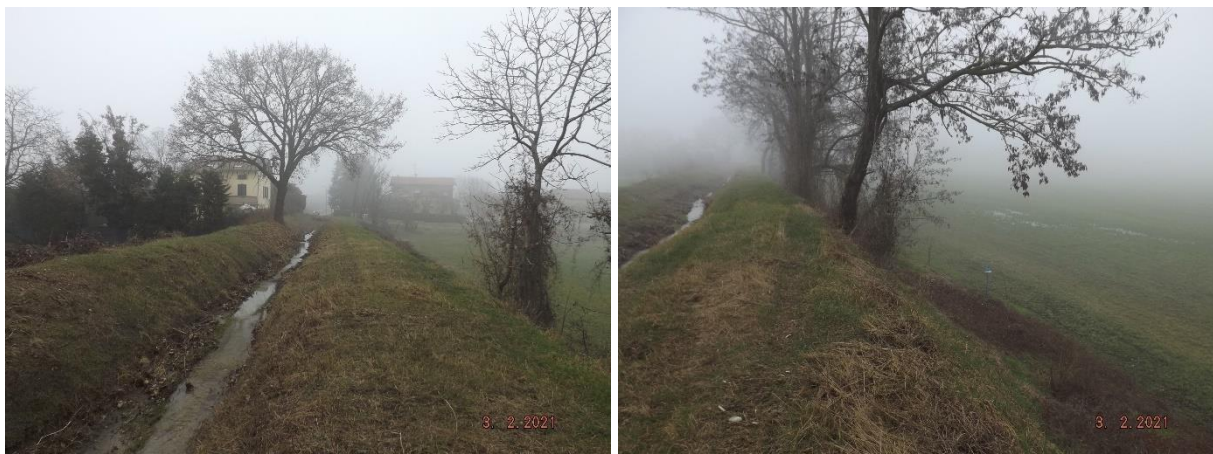
FIGURA 5-8 – RIO ENZOLA, TRATTO TERMINALE PENSILE A MONTE DELLO SCOLMATORE A BIBBIANO
