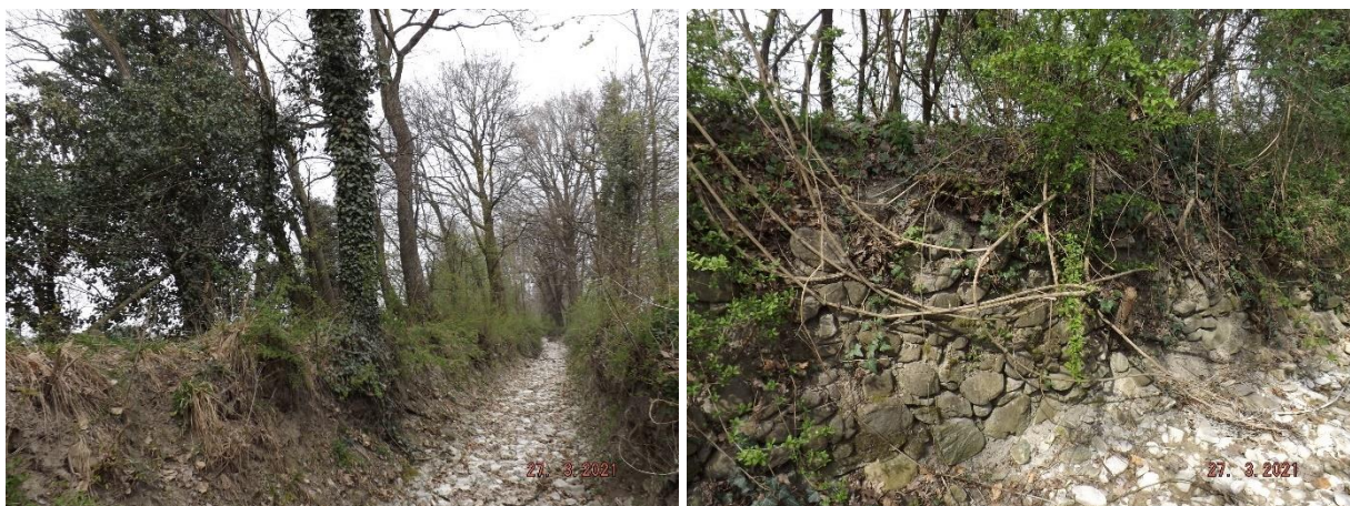
FIGURA 5-6 – RIO ENZOLA, VEGETAZIONE SPONDALE E RIVESTIMENTI IN PIETREME
