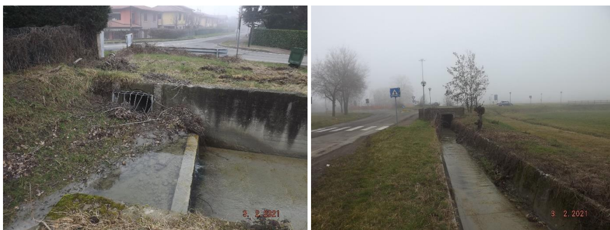
FIGURA 5-9 – RIO ENZOLA, MANUFATTO SCARICATORE A BIBBIANO
