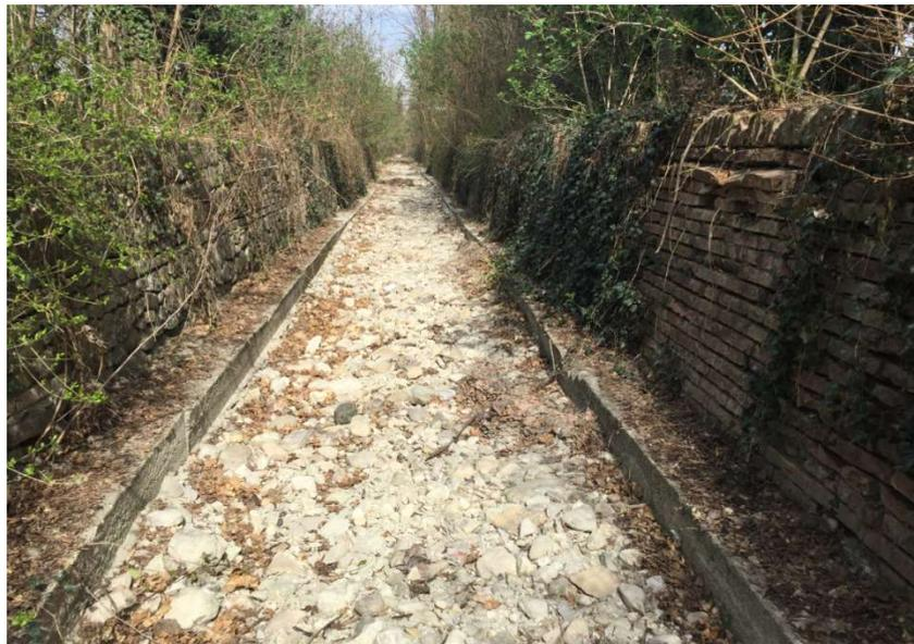
**Figura 2-6 – Tratto di alveo con rivestimento delle sponde in muratura e cordoli laterali di fondazione in c.a.**
