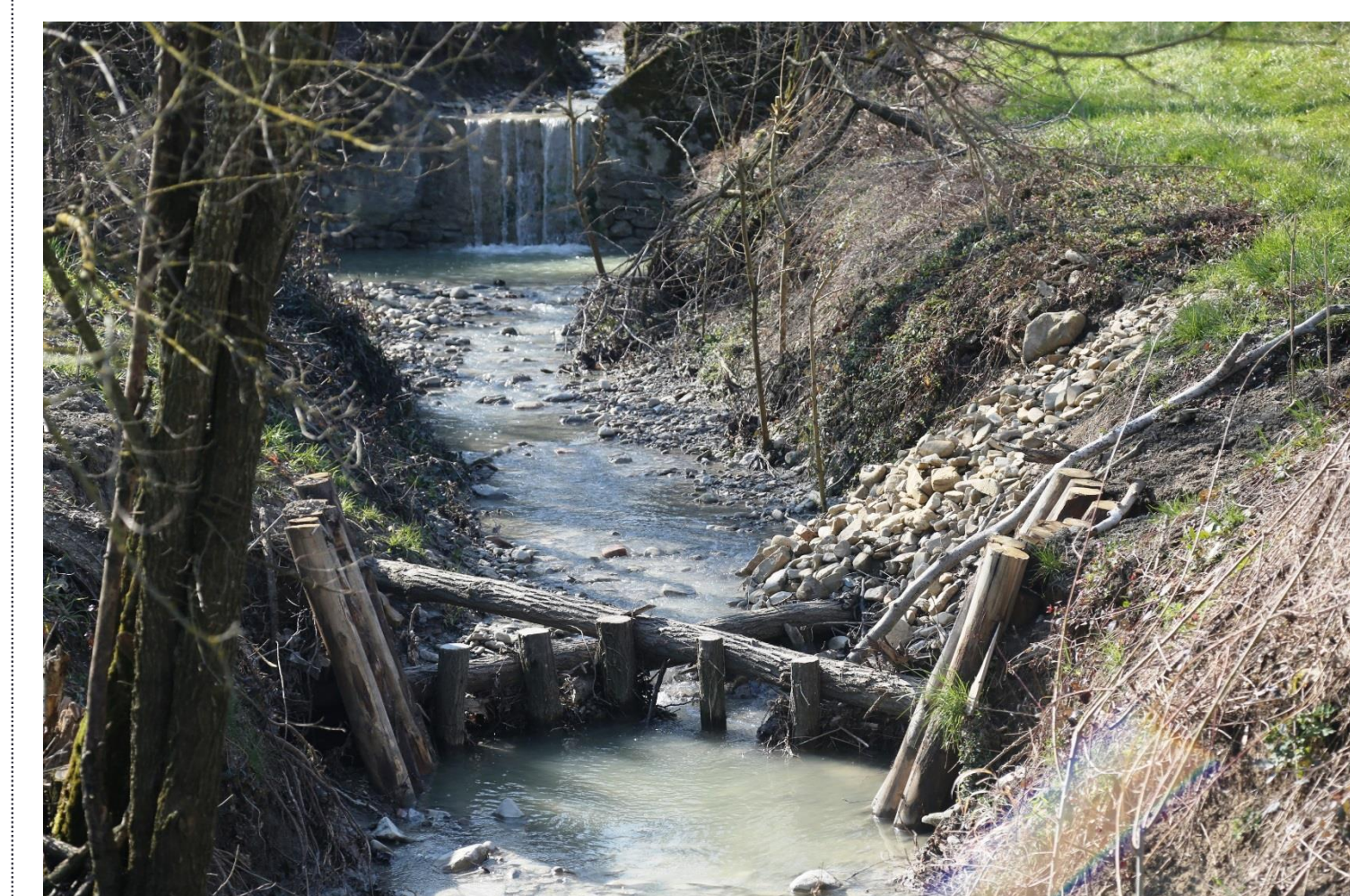
FOTO 2 – SALTO NATURALIFORME LUNGO IL RIO ENZOLA A MONTE DELL'ABITATO DI QUATTRO CASTELLA (RE)
