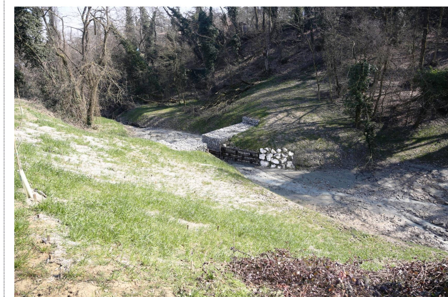
FOTO 3 – RESTRINGIMENTO IN PIETRE RINVERDITO LUNGO IL RIO BIANELLO A MONTE DELL'ABITATO DI QUATTRO CASTELLA (RE)
