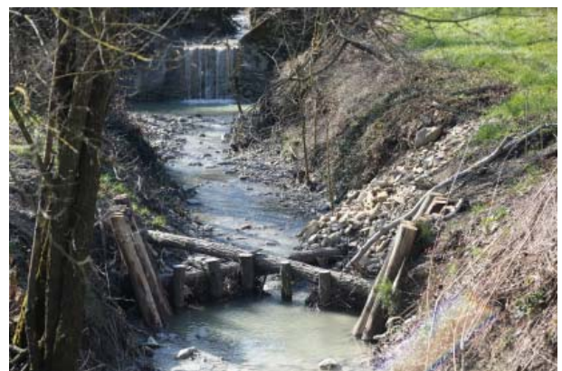
Fig. 4. Salto di fondo naturaliforme utilizzato per la riconnessione di lembi golenali all'alveo attuale.
