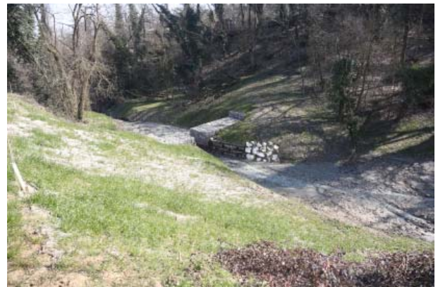
Fig. 3. Il restringimento in pietrame rinverdito realizzato nel tratto collinare del rio Bianello (affluente del rio Quaresimo). A monte della struttura è visibile parte della nuova golena.
