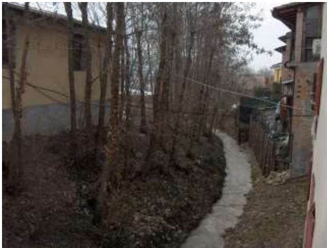
Figura 15. Alveo del rio Bottazzo invaso da manufatti che ne riducono pericolosamente la larghezza
