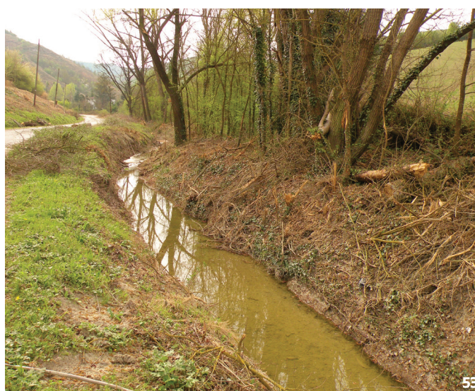
Figura 3. Rio nella Vena del Gesso Romagnola dopo i lavori di controllo della vegetazione arboreo-arbustiva
