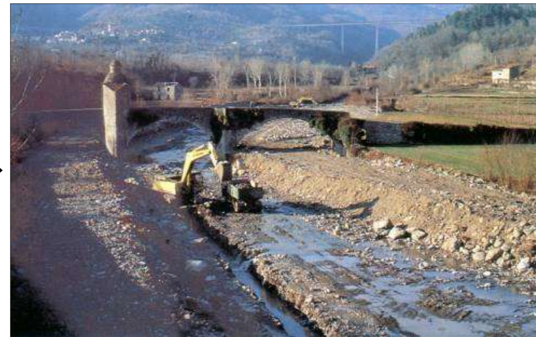
Rimozione della vegetazione
