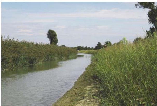
Fig. 5. A sinistra: Collettore Alfiere nel tratto 1 a circa 6 mesi dalla fine dei lavori; sponda destra arretrata e riprofilata al fine di garantire una pendenza della scarpata non superiore a 1:2 e favorire così la colonizzazione di specie elofitiche. A destra: particolare di una bassura umida, in cui si nota la colonizzazione in corso da parte della vegetazione.
